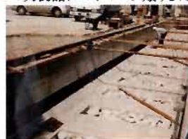
二次製品にバイオマーク貼りした施工現場
