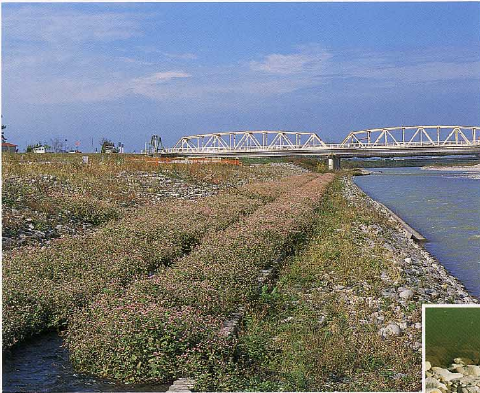
石川県 手取川湊護岸工事
