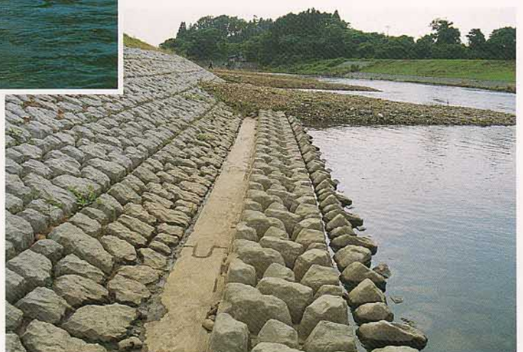
石川県 梯川荒木田護岸工事
