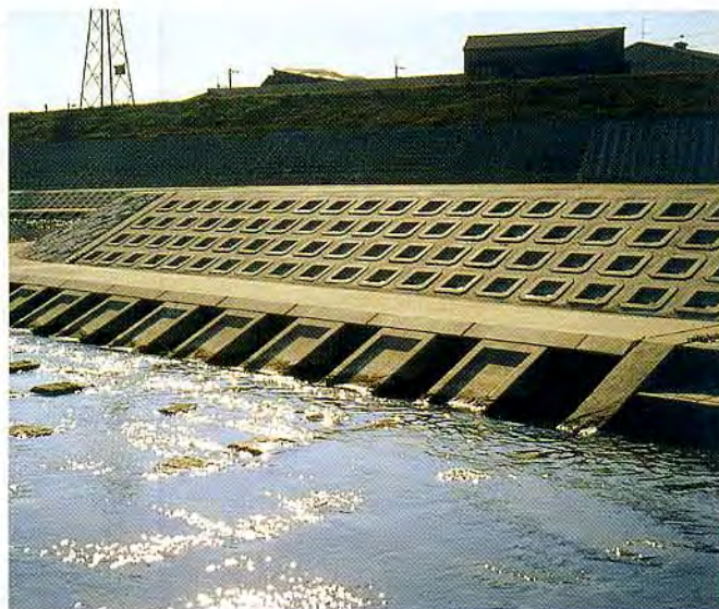
大阪府 安威川改修工事
