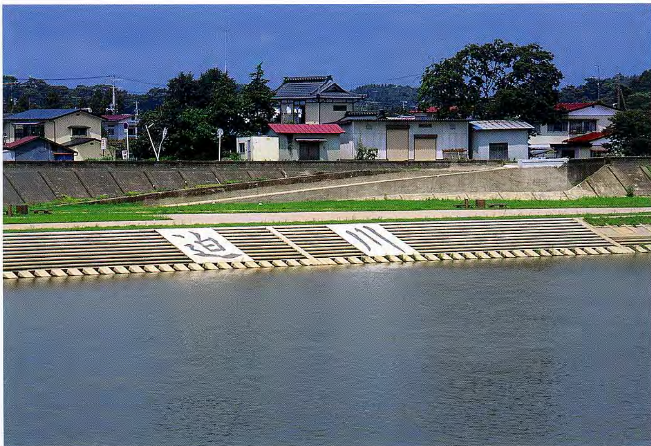
宮城県 迫川河川局部工事
