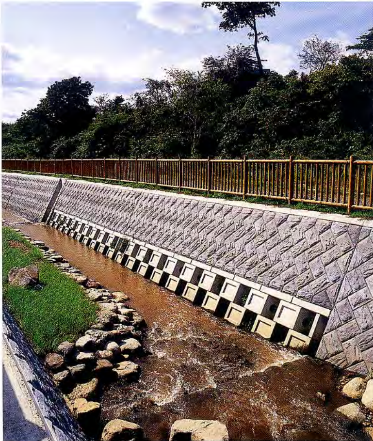
北海道 石川都市河川改修工事
