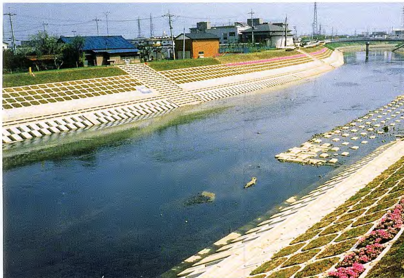
神奈川県 鈴川改修工事
