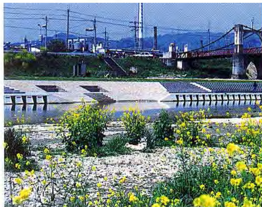
大阪府 安威川改修工事
