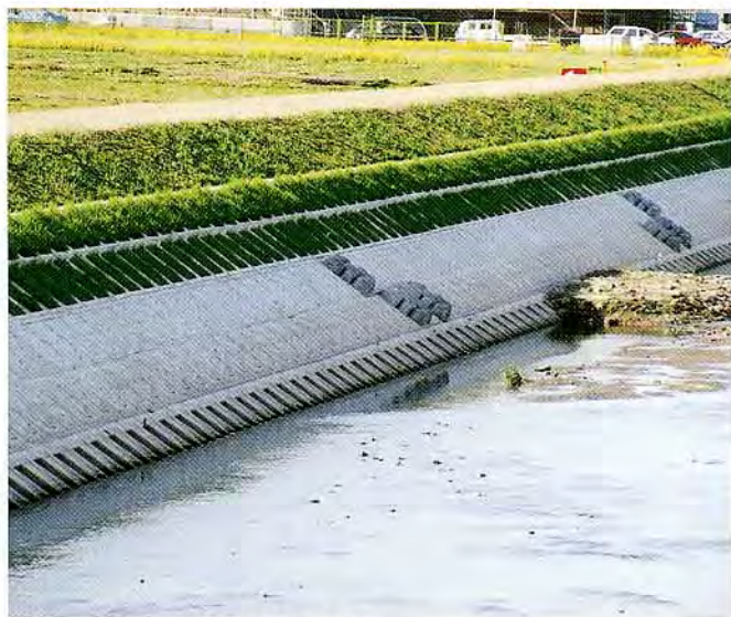
岐阜県 公共小規模河川改修工事
