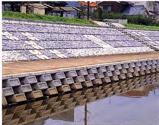
愛知県 地蔵川改修工事
