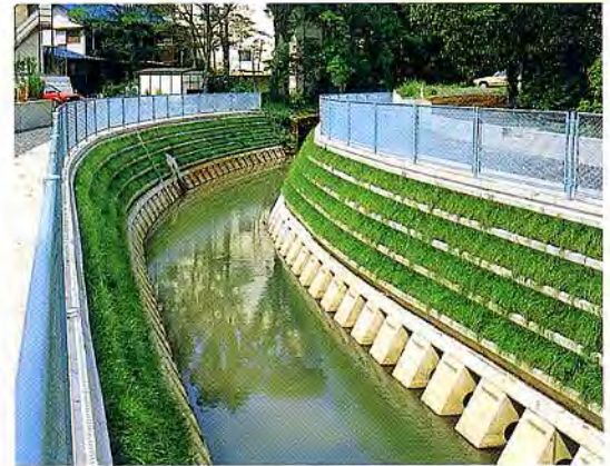
神奈川県 狹川改修工事
