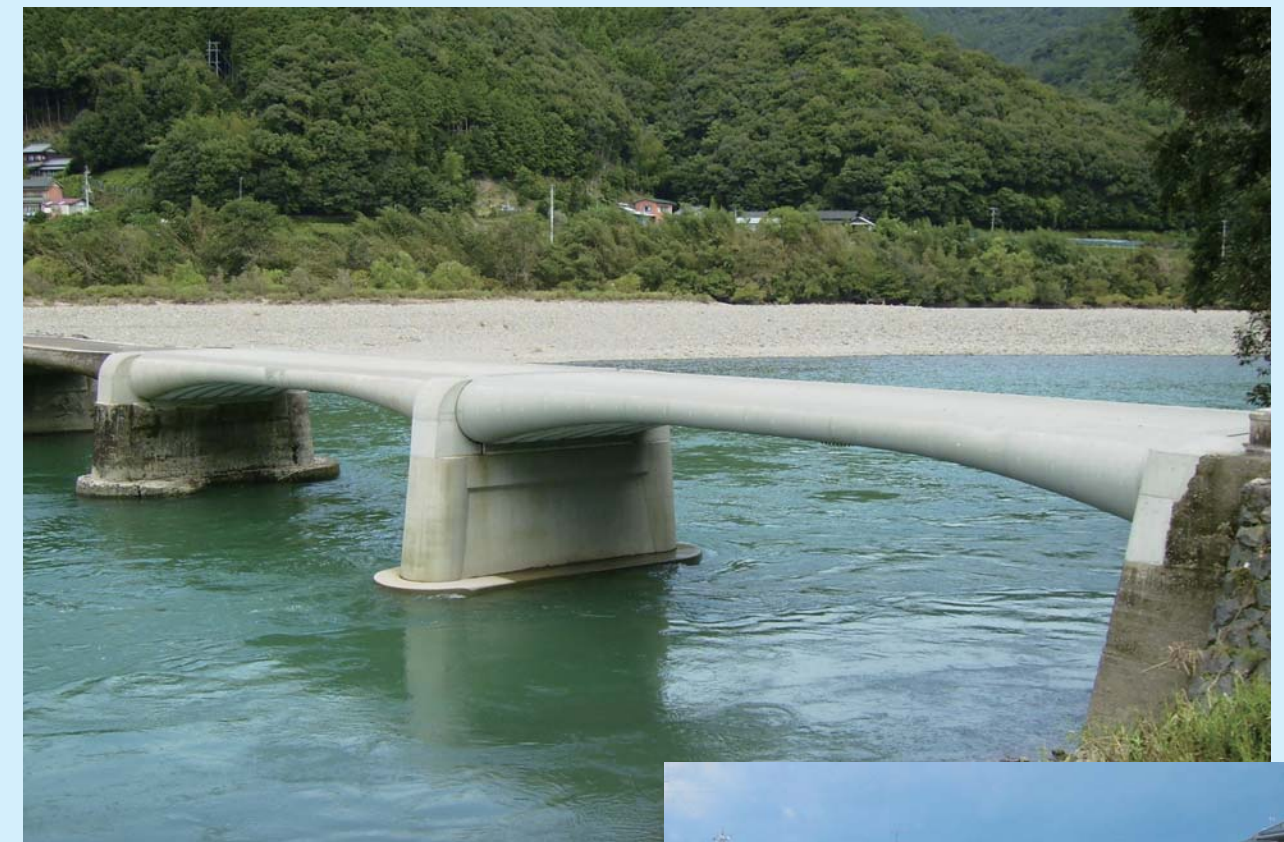
四万十川(屋内大橋) 2径間架替 橋長15.25m 高知県四万十市(平成26年3月架橋)
