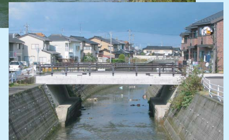
太郎田橋上部工架替工事 橋長13.10m 石川県金沢市(平成16年9月架橋)
