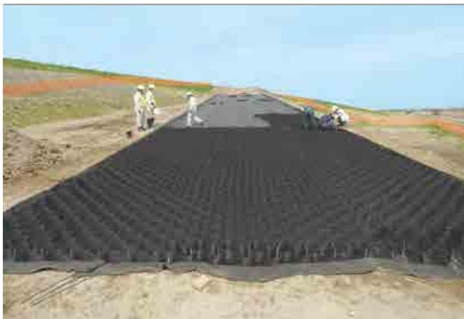
タイプ▶M150 面積▶770m<sup>2</sup> 道路幅▶7m 道路勾配▶10% 充填材▶碎石
