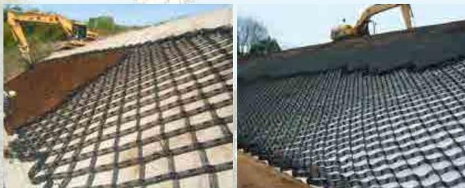
ジオウエツプを法面の天端より法尻方向に展開し、展開用アンカー・すべり止め用アンカーの打設で外周のセルを固定し、簡単に法面を被覆できます。これに、充填材を投入し法面保護工が完成します。景観設計に基づき多種多様な充填材を使用できます。
