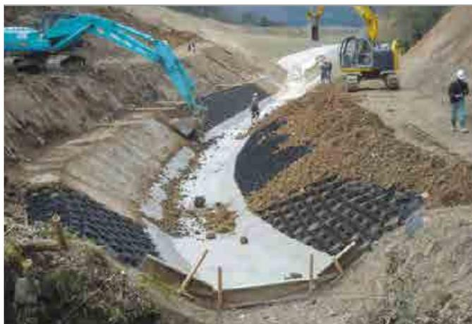
タイプ▶L100 面積▶320m<sup>2</sup> 充填材▶上部=発生土、下部=コンクリート
