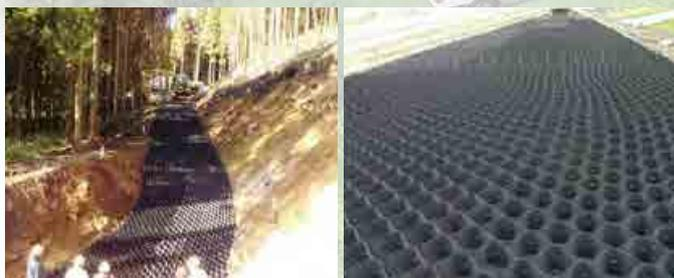
ジオウエツプと拘束した充填材との相乗効果で高い荷重分散効果を持った支持層を形成します。セル内に砕石を充填すれば仮設道路として工事車両の通行もでき、災害時の早急な道路確保に威力を発揮します。斜路や林道のわだち掘れ止効果にも有効です。
