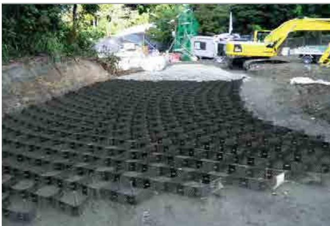
タイプ▶L100 面積▶300m<sup>2</sup> 道路幅▶5m 道路勾配▶15~18% 充填材▶クラシャーラン
