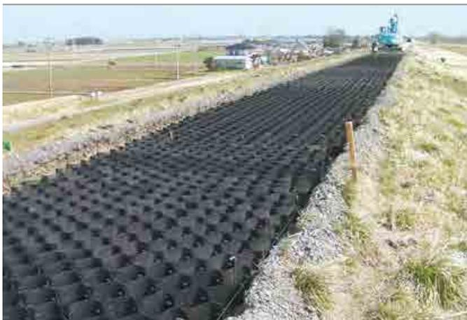
タイプ▶M150 面積▶5,600m<sup>2</sup> 道路幅▶3m 充填材▶碎石
