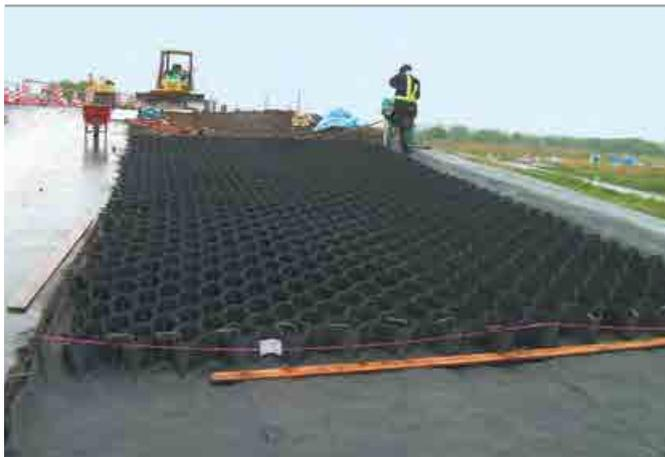
タイプ▶M150 面積▶800m<sup>2</sup> 道路幅▶4.5m 道路勾配▶6% 充填材▶碎石
