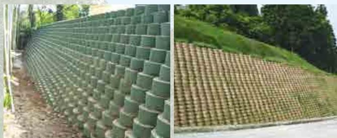
水平に展開したジオウェブに砕石や土壌(前面セル)を充填転圧し、階段状に積み上げて擁壁構造体を構築します。
