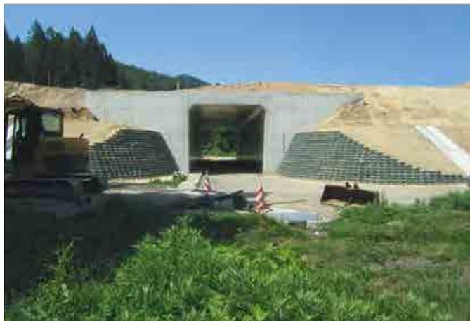
タイプ▶R3-G 面積▶225m<sup>2</sup> 勾配▶1:0.5 直高▶3m 充填材▶砂質土
