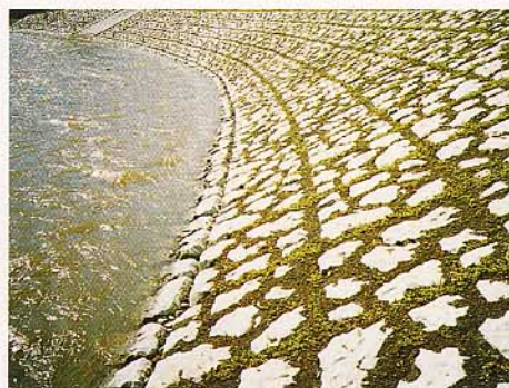
青森県 田子川小規模河川改良工事
