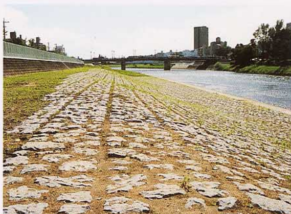
熊本県 白川本荘護岸災害復旧工事
