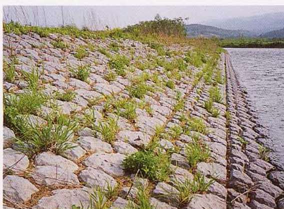
北海道 天塩川改修工事の内ペンケニューブ川左岸 名寄市大反橋下流地先災害復旧工事
