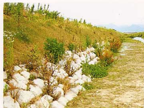
山形県 槇川小規模河川改良工事
