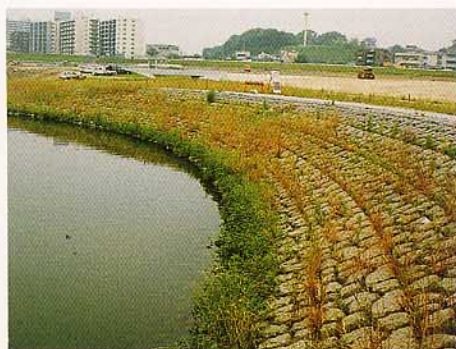
近畿地方建設局淀川工事事務所 枚方第11低水護岸工事
