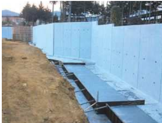
施工状況（底版部現場打ち）
