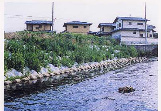
茨城県 桜川広域河川工事
