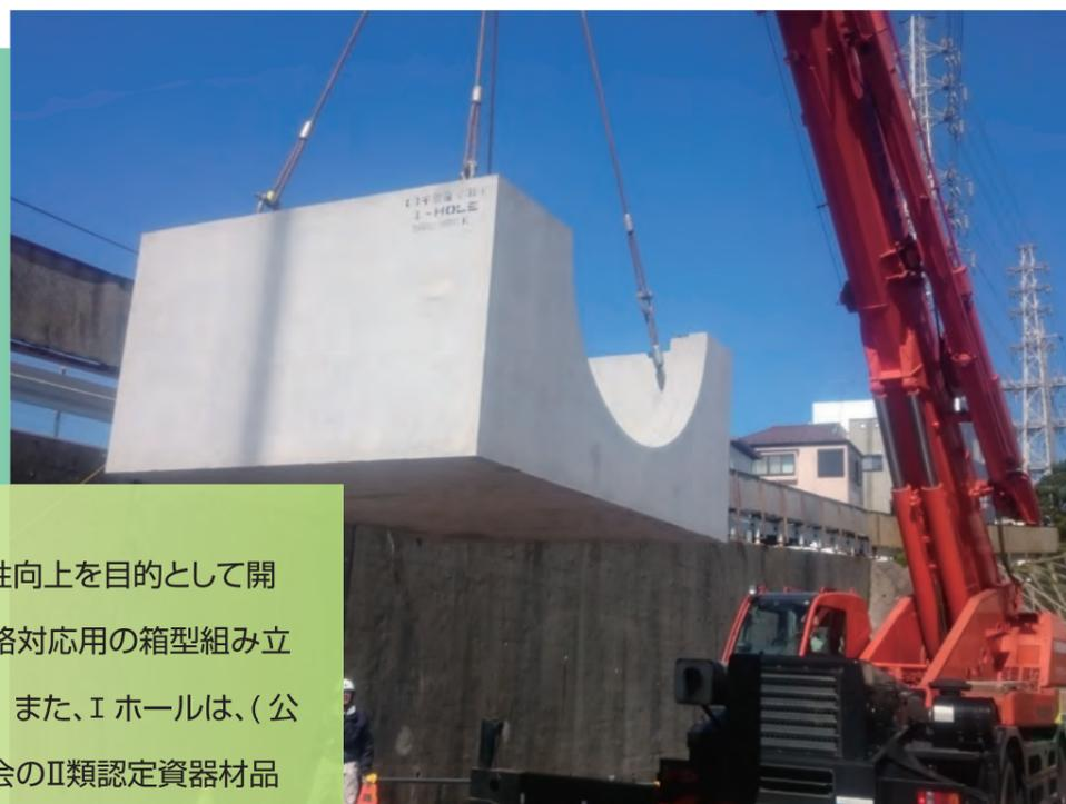
Iホールは、施工性向上を目的として開発された大口径管路対応の箱型組み立てマンホールです。また、Iホールは、(公社)日本下水道協会のⅡ類認定資器材品(下水道用組立マンホール側塊)です。
