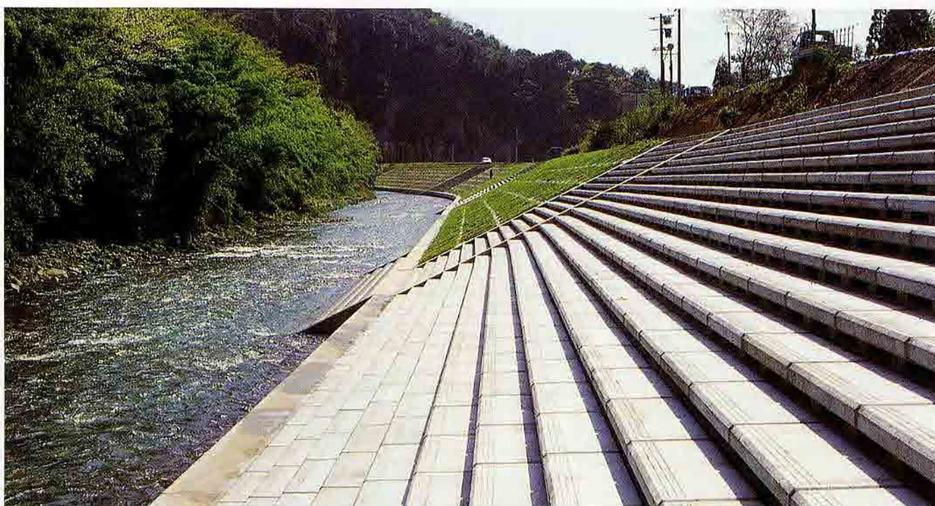
鹿児島県万之瀬川護岸改修工事
