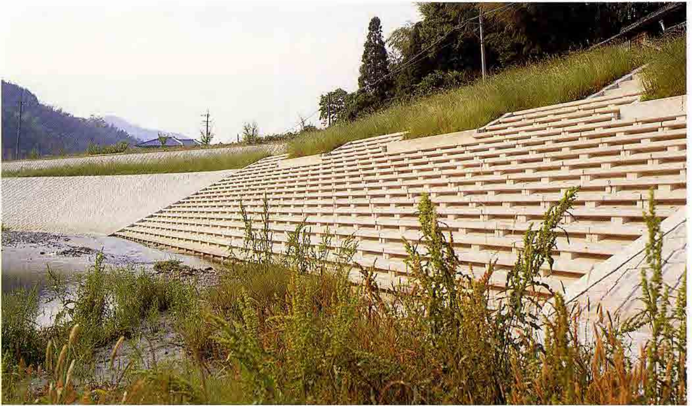
福岡県 白木川災害復旧助成工事
