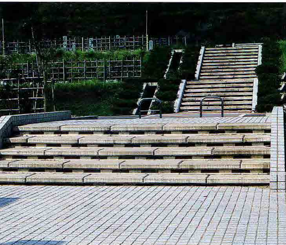
愛知県松ノ岩墓園造成工事
