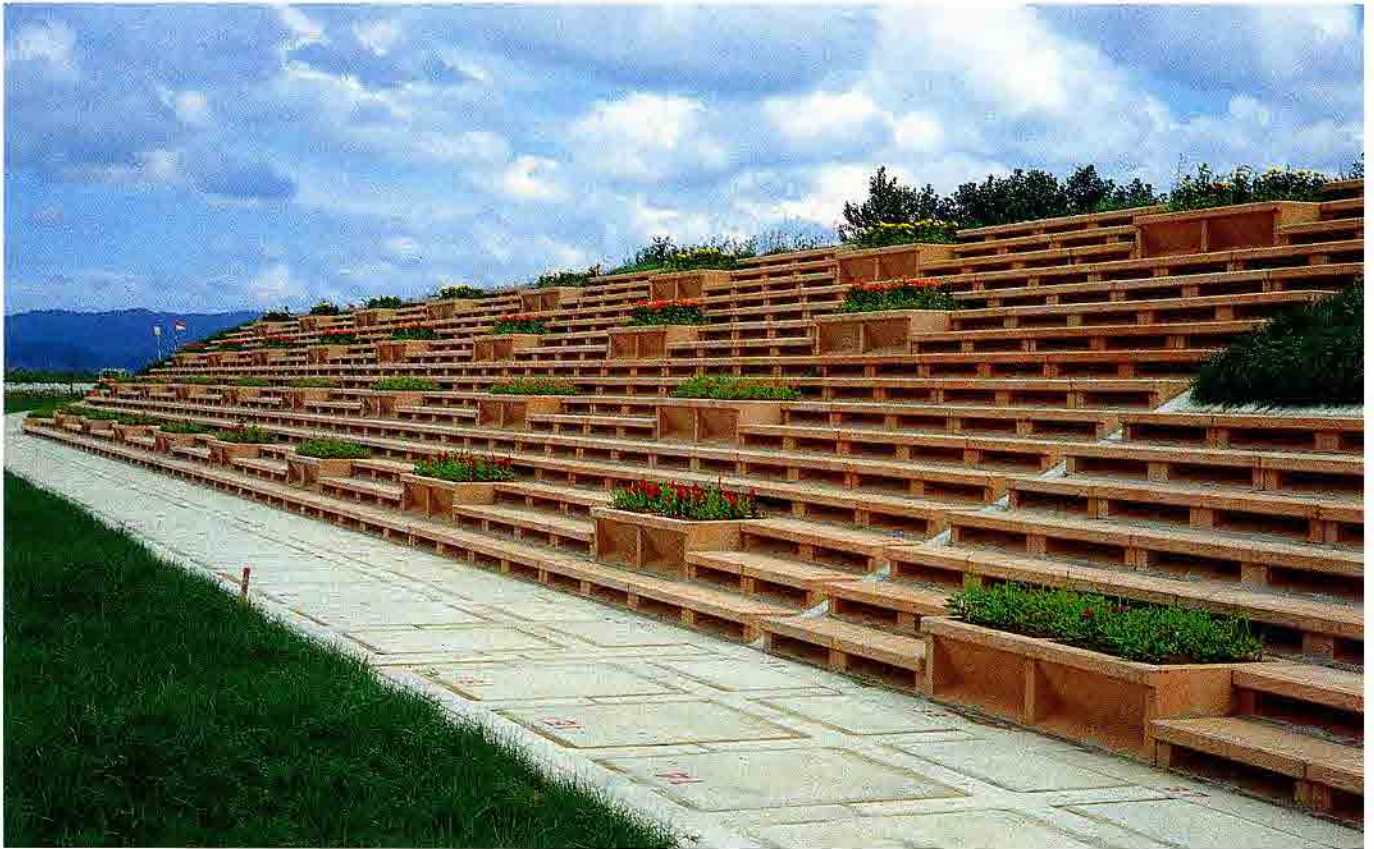
北海道天塩川河川改修工事
