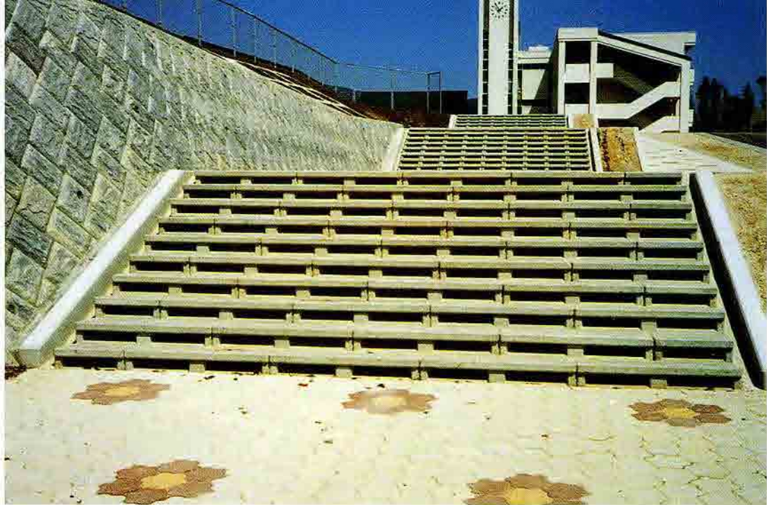
福岡県篠栗町北中学校工事
