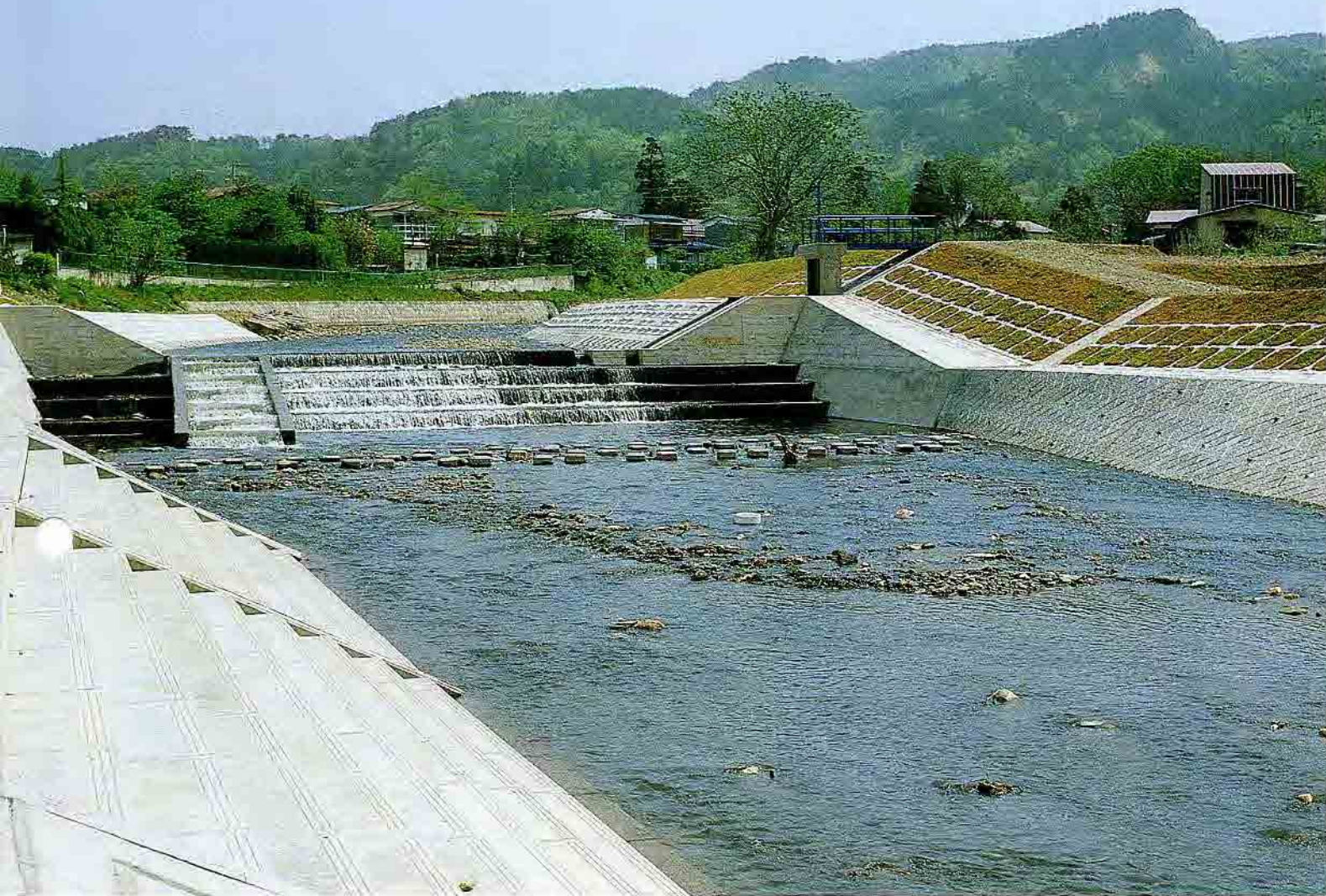
福島県湯川中小河川改良工事
