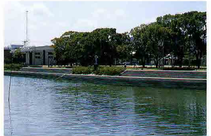
長崎県 佐世保川河川環境整備工事
