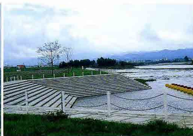
北海道 石狩川河川環境整備工事
