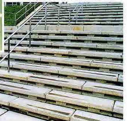
北海道共栄中学校敷地内造成工事
