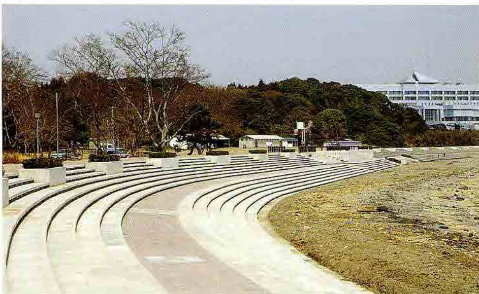
大分県糸ヶ浜海岸整備工事
