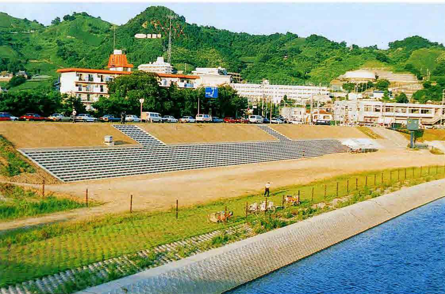
大阪府 大和川改修工事
