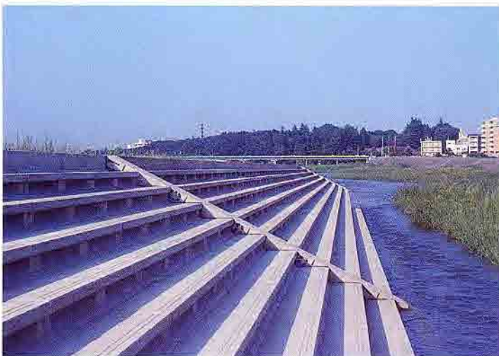
栃木県 思川中小河川改修工事
