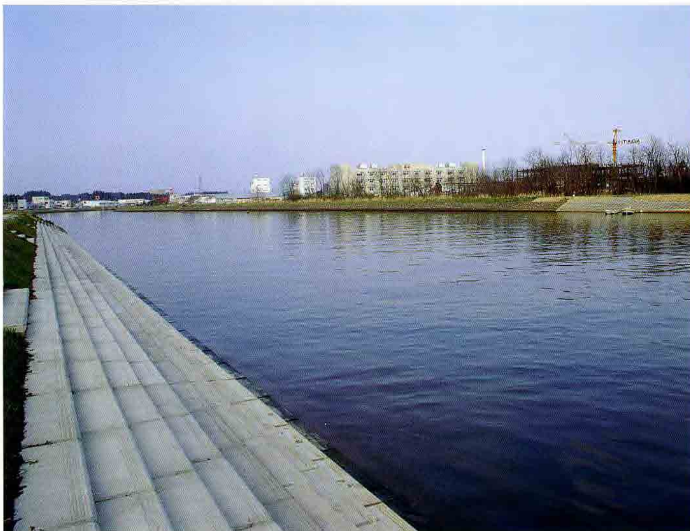
青森県田名部川中小河川改修工事
