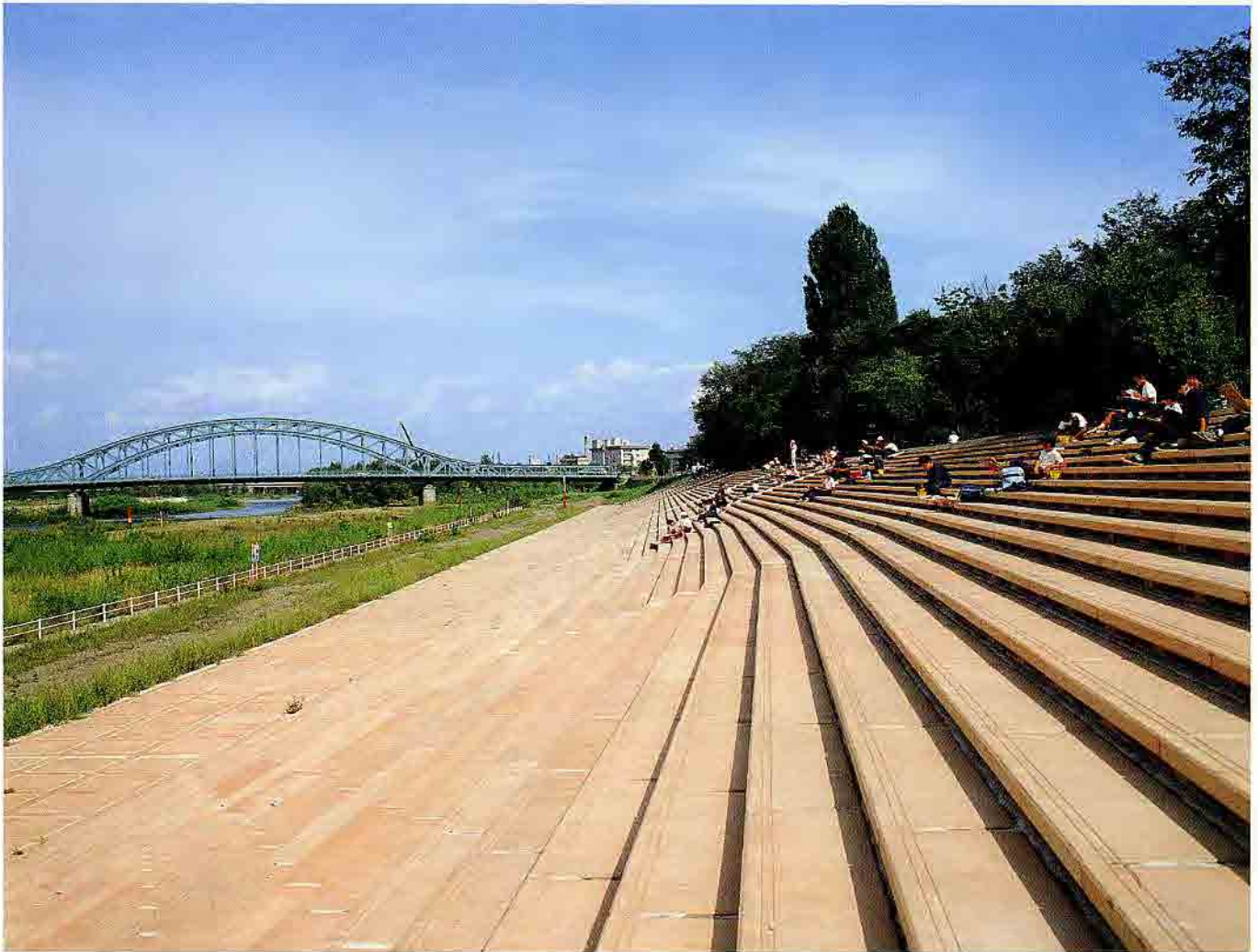
北海道 石狩川旭橋河川環境整備工事
