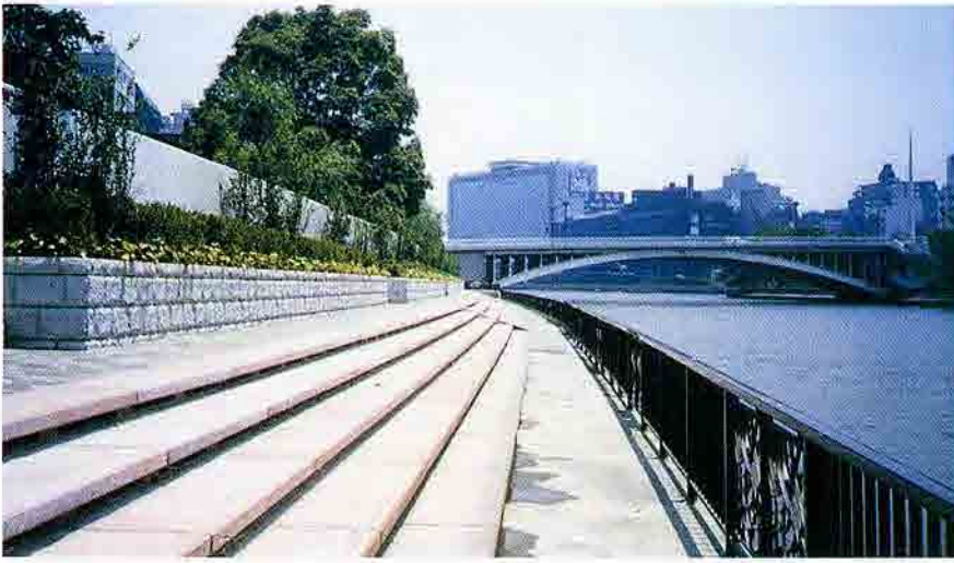
大阪府 堂島川河川改修工事
