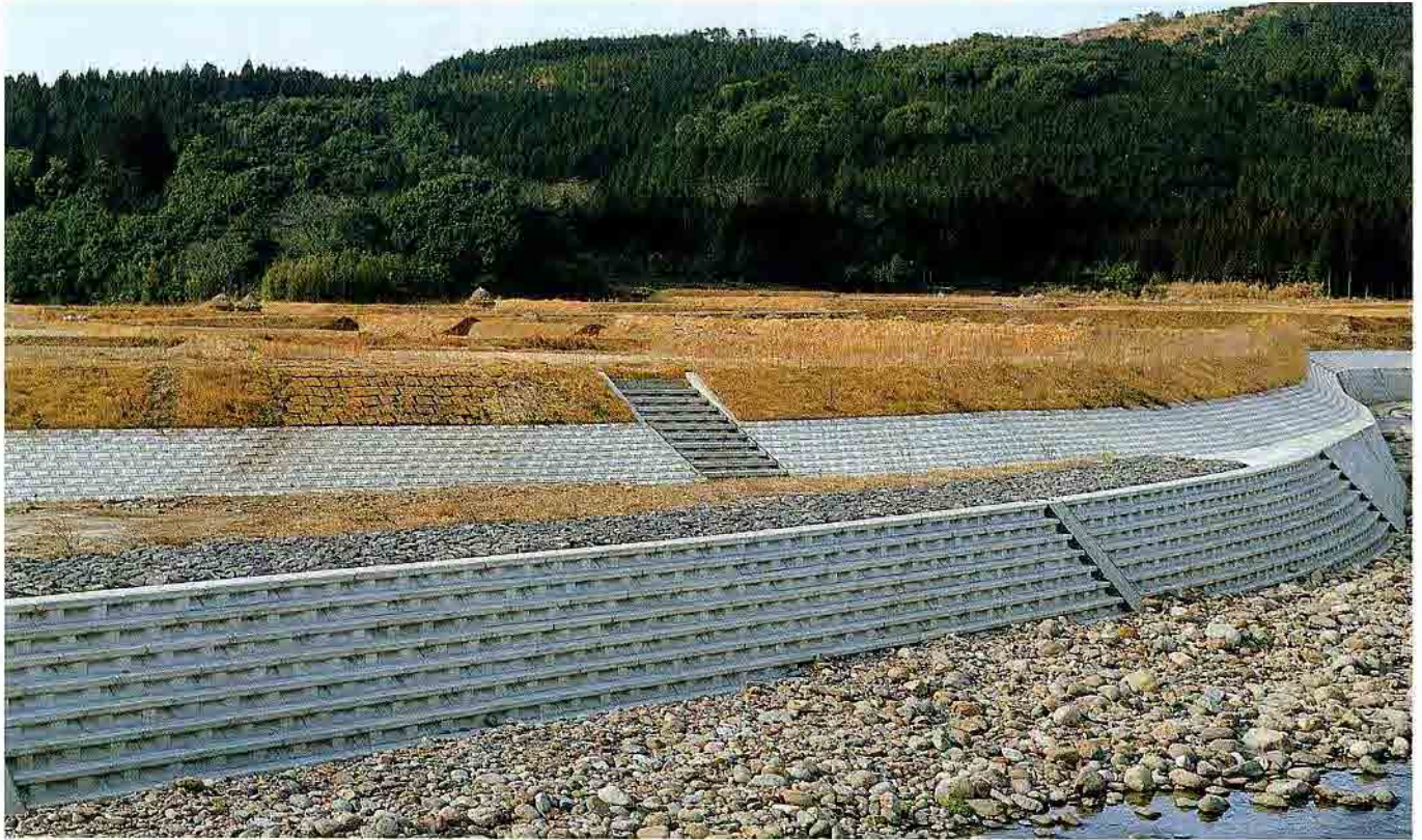
鹿児島県十曾川災害復旧工事
