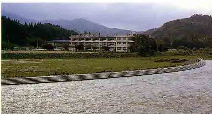
福島県 久慈川河川改良工事
