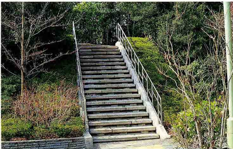
東京都南多摩新開発本部宅地造成工事
