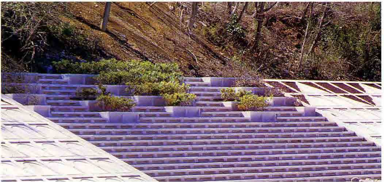
東京都 秋川防災工事
