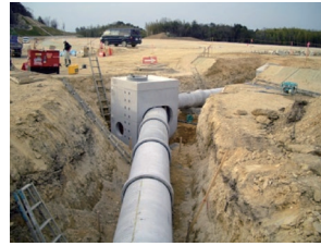
ヒューム管接続
