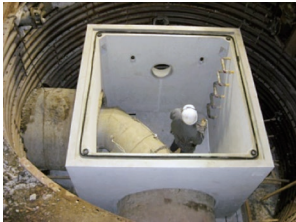
割り込み人孔 (基礎部現場打ち)
