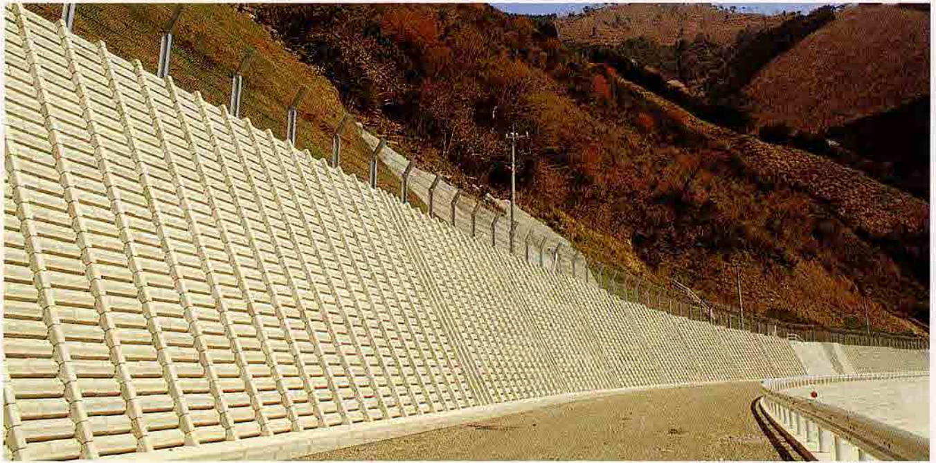
熊本県 付替村道金川地区擁壁工事
