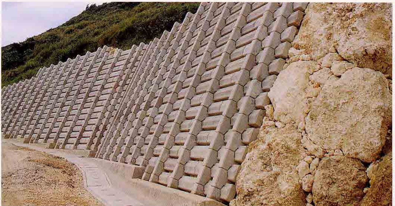
沖縄県宮古島 町道339号線災害復旧工事
