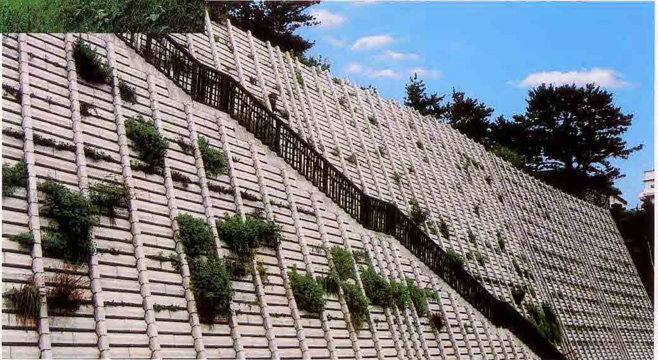
愛知県 緊急傾斜地崩壊対策工事
