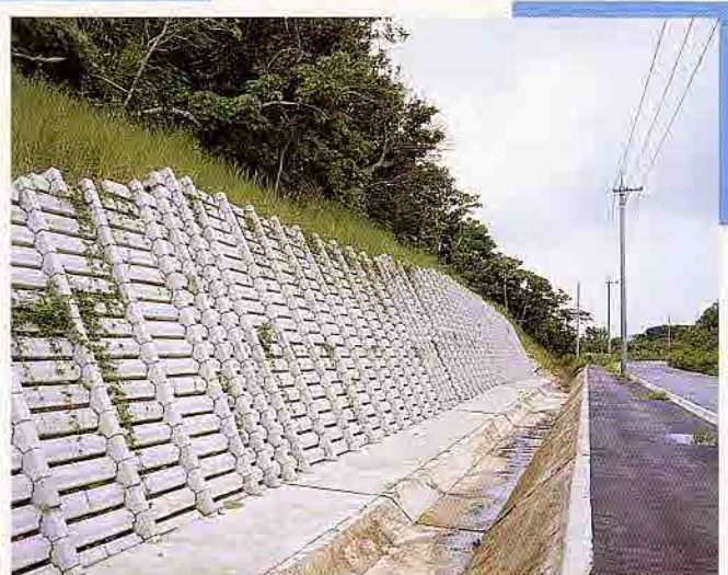
沖縄県石垣島 白浜南風見線災害復旧工事
