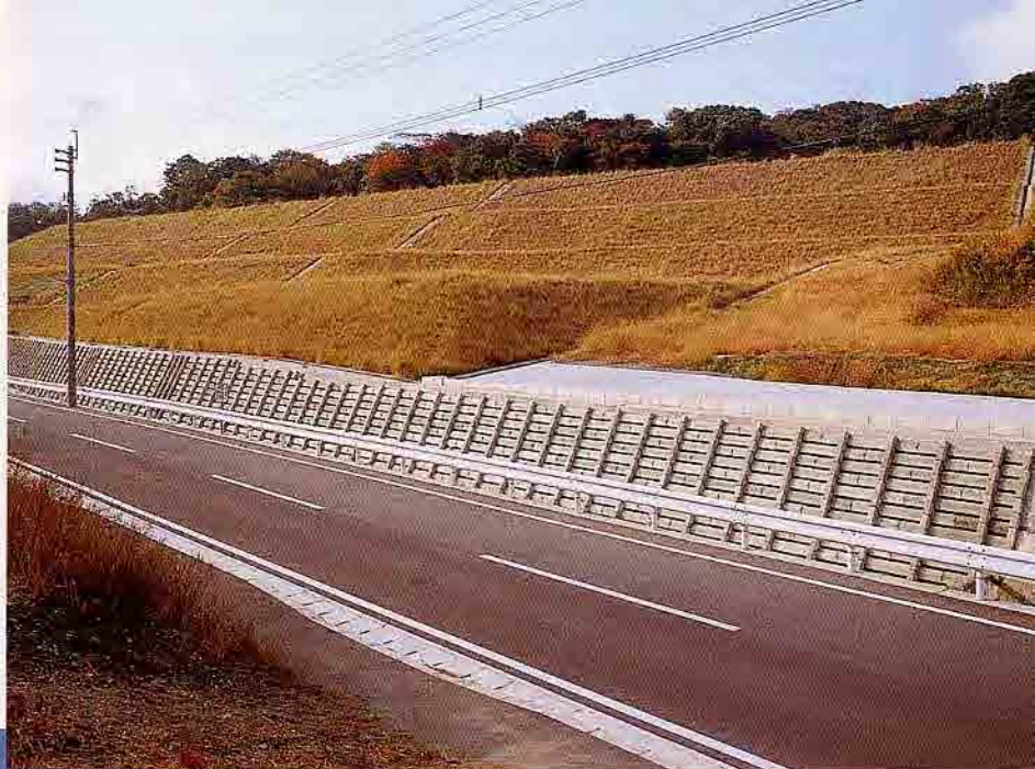
福岡県 ぼた山防災工事
