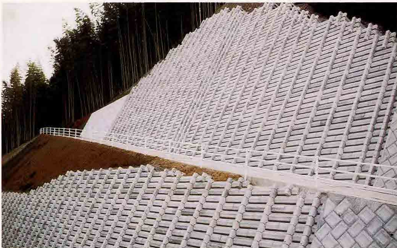
大分県 県道安心院湯布院線道路改良工事
