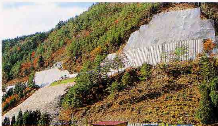
岐阜県 阿多岐ダム付替道路工事
