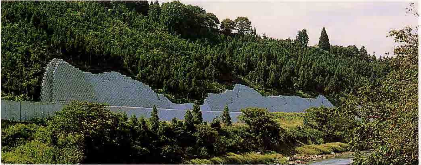
長野県 国道117号道路改良工事
