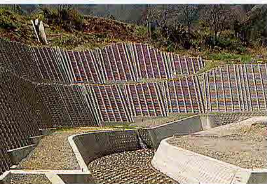
鳥取県 通常砂防滝川 流路工工事
