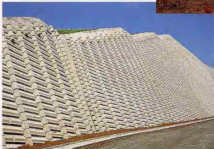
福岡県 須恵中学校造成工事
