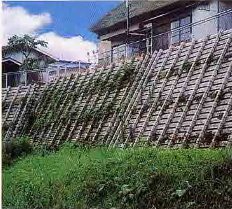
秋田県 上荒川地区急傾斜地崩壊対策工事
