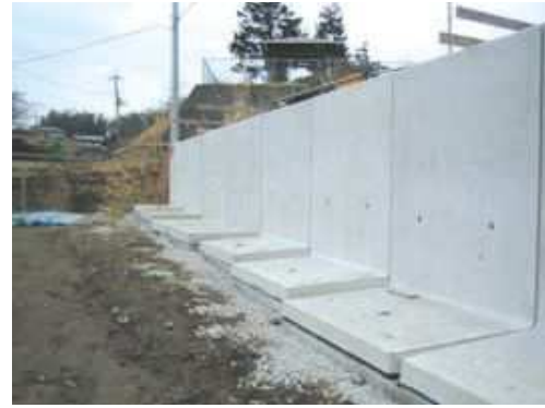
敷き段差施工
