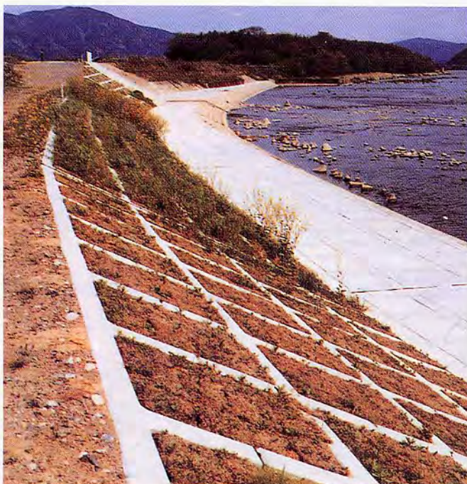
京都府 桂川防災施設工事
