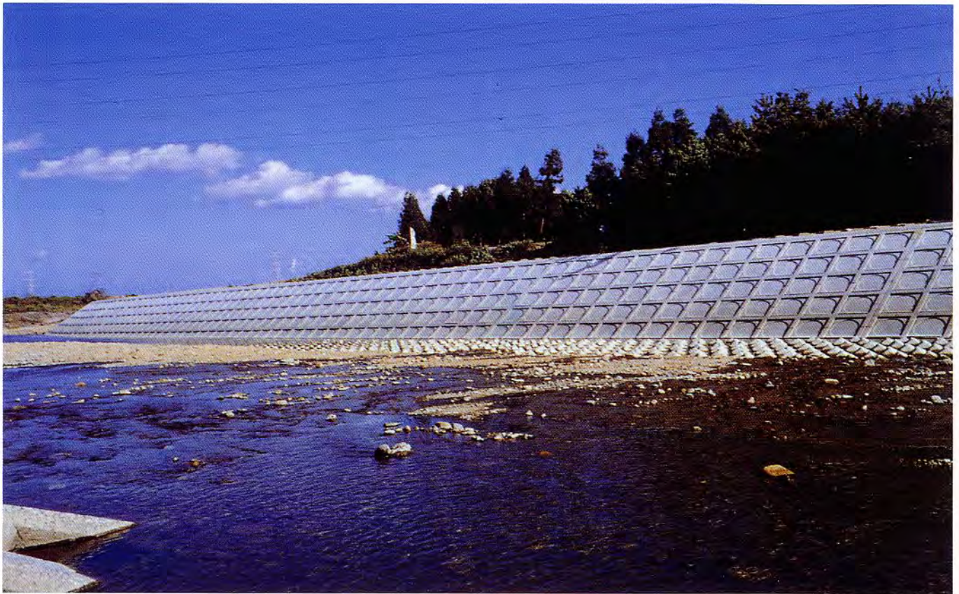
三重県 安楽川災害復旧工事
