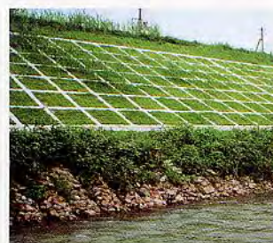
奈良県 竜田川改修工事
