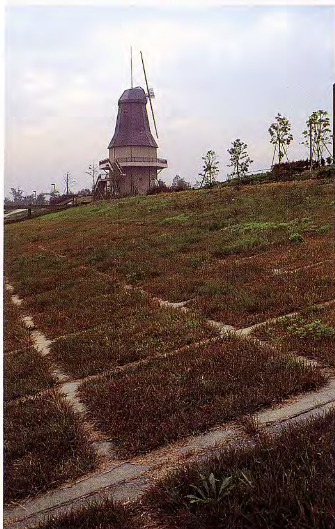
茨城県 大岩田築堤護岸工事
