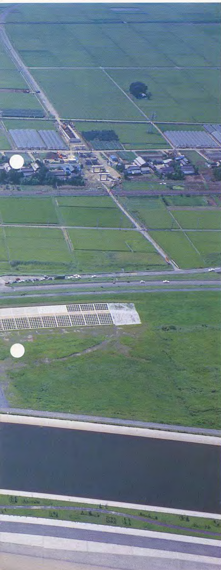
柏戸高水護岸工事
