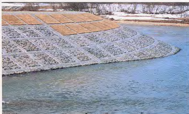
秋田県 横手川県単河川改良工事
