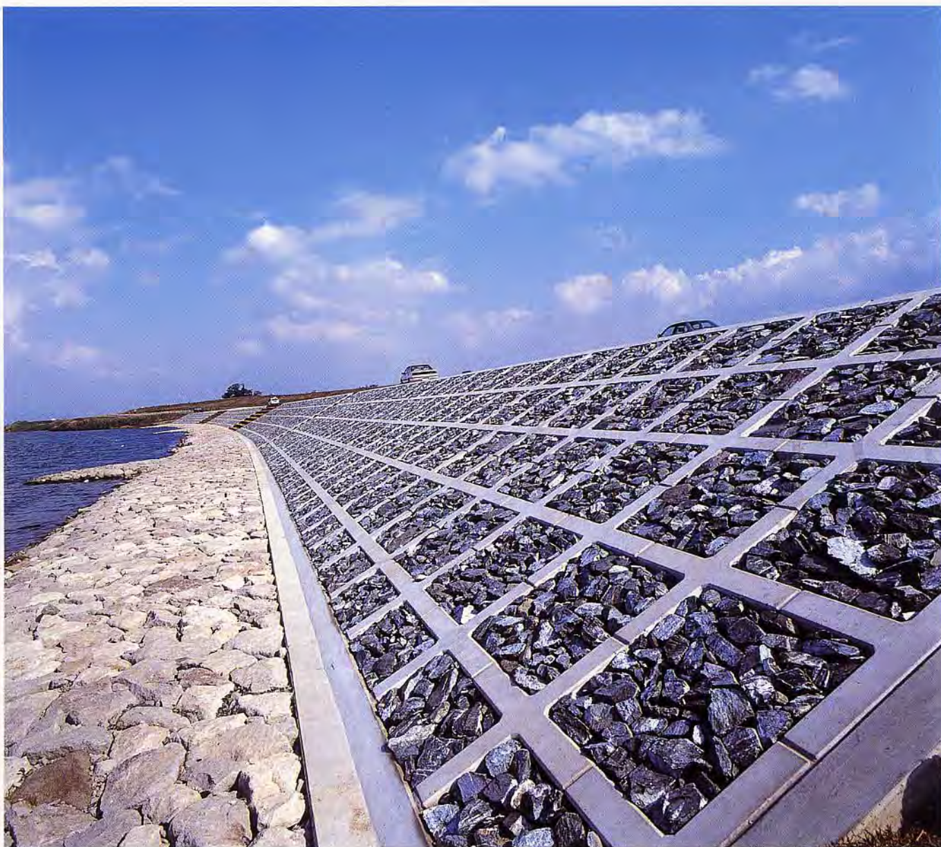
福岡県 太郎原護岸根固災害復旧工事
