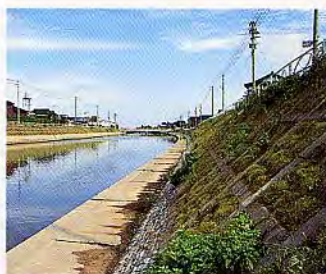
富山県 仏生寺川環境整備事業工事
