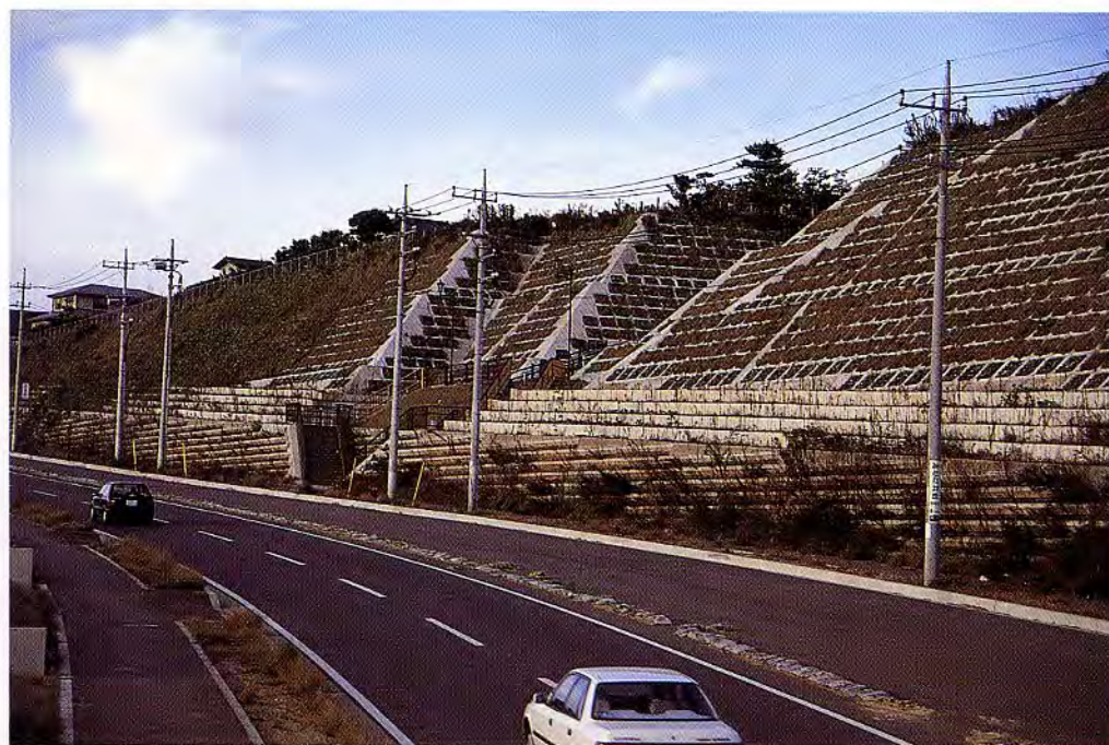
茨城県 鹿島市役所国補鹿区道路築造工事
