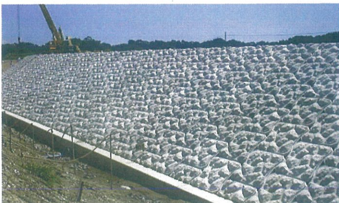
宮城県 松島護岸 擬石ブレストン
