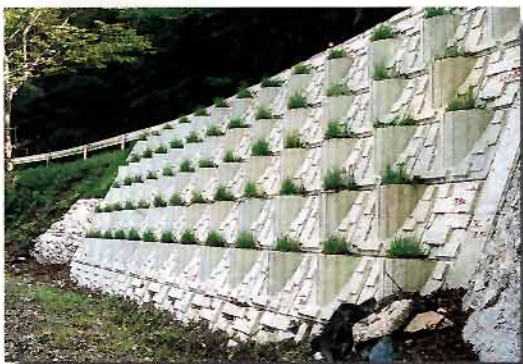
岩手県 江刺室根線道路災害復旧工事
