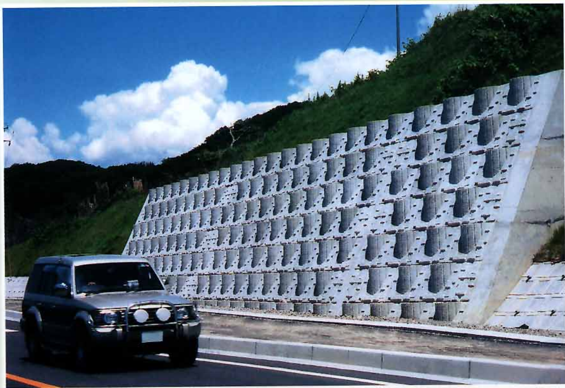
秋田県 芦川橋架替工事
