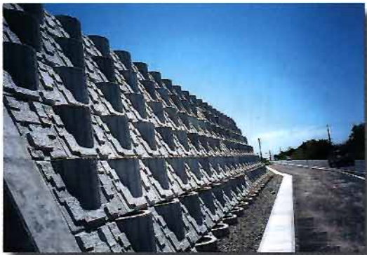
秋田県 芦川橋架替工事
