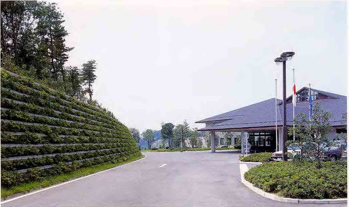
千葉県白鳳カントリークラブ造成工事
