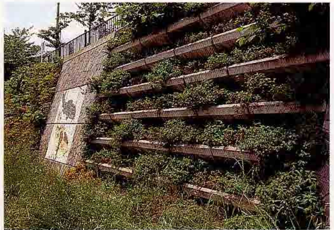
愛知県都市小河川山崎川改修工事
