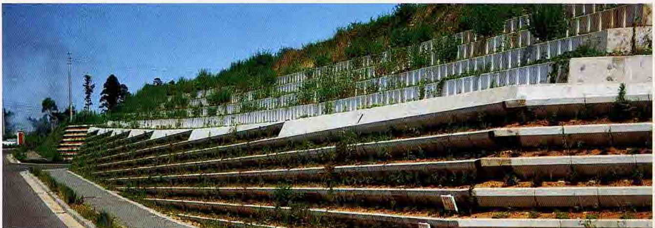
茨城県鹿島神宮駅北都市街区整備工事
