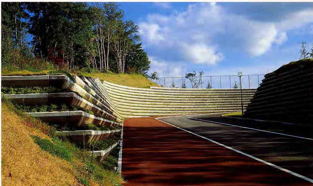
北海道北海学園大学グラウンド造成工事
