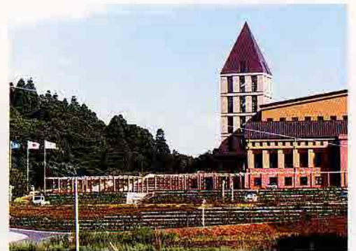
千葉県御宿町役場外構工事
