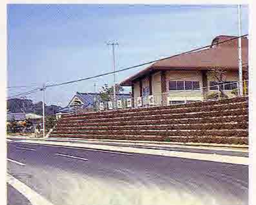
鹿児島県国道328号道路改良工事
