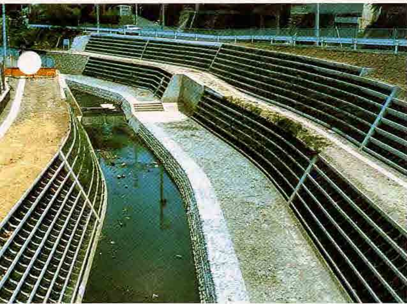
神奈川県黒須田川河川改修工事
