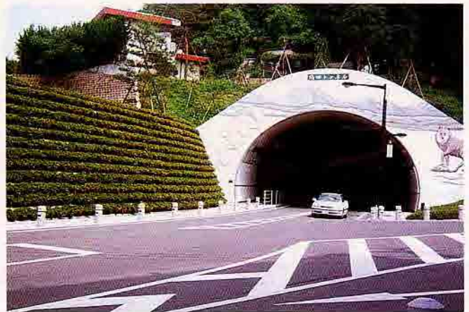
栃木県県庁周辺整備工事
