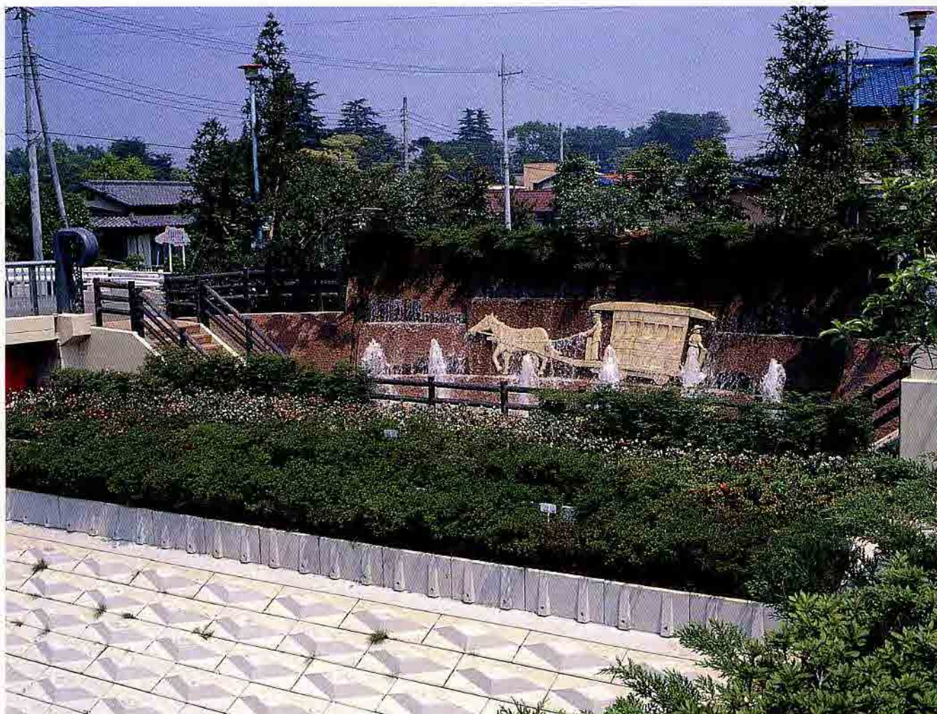
埼玉県大落古利根川改修工事
