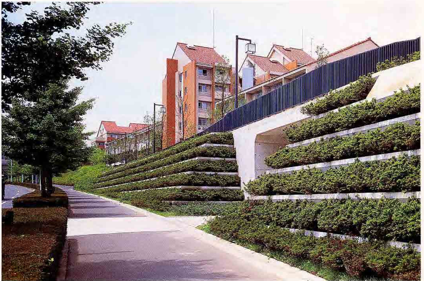
東京多摩ニュータウン南大沢地区工事
