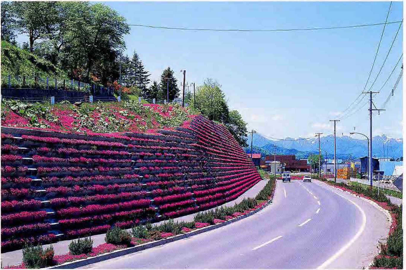
北海道滝の上公園造成工事
