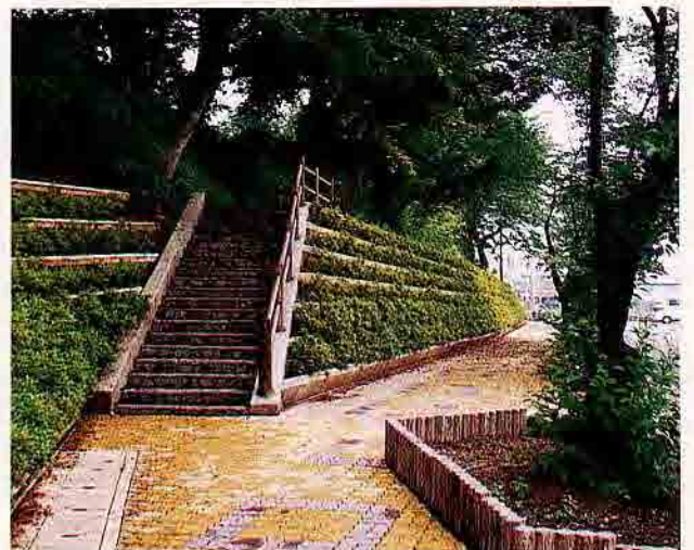
栃木県急傾斜崩壊対策工事
