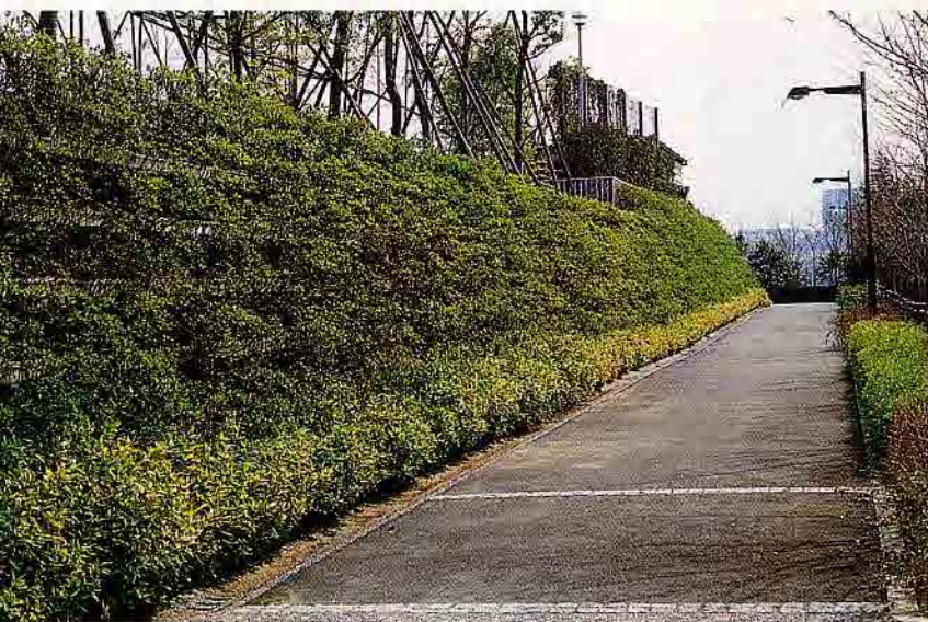
東京都南多摩新開発本部造成工事
