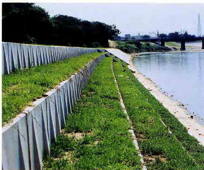
大阪府大和川常盤築堤護岸工事
