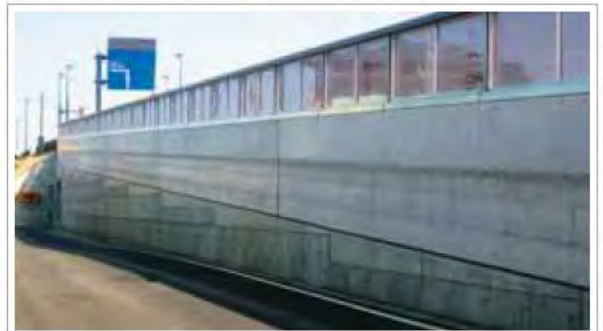
遮音壁の設置例
