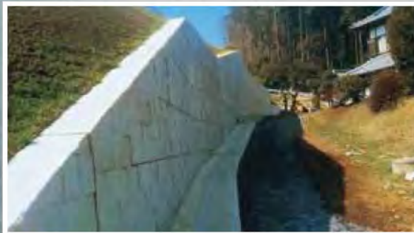
壁面材の上部をカットした例
