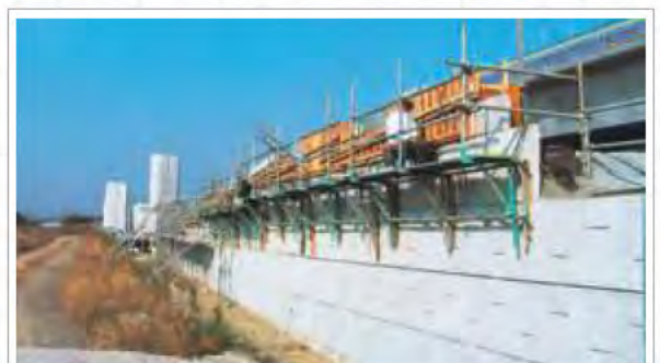
施工時のつり足場設置例
