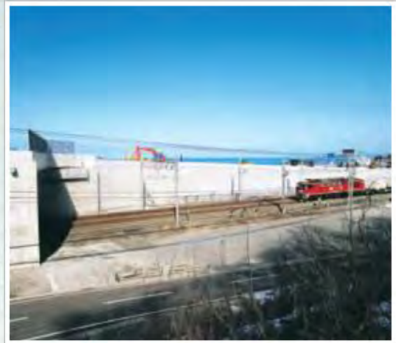
施 主：国土交通省高田河川国道事務所 工 事 名：能生大橋付替道路他工事 概算壁面積：960㎡
