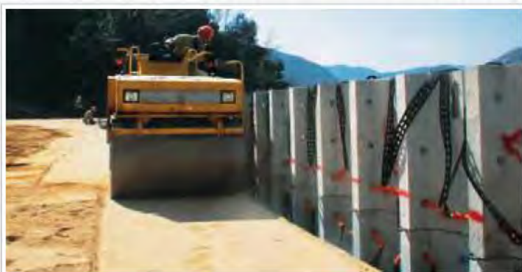
[重機による壁面近傍の転圧状況]
