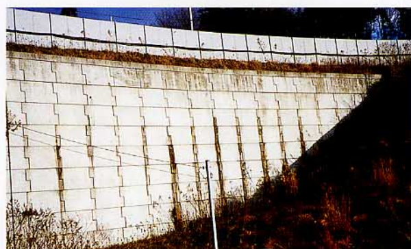
写4. 壁高11mの多数アンカー式補強土壁
