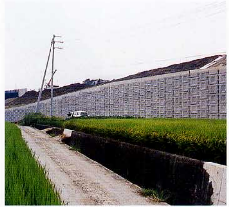
日本道路公団 四国・脇町工事事務所 —三好東工事—
