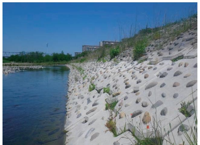
用途：河川護岸工・法覆工・天端保護工・高水敷保護工
