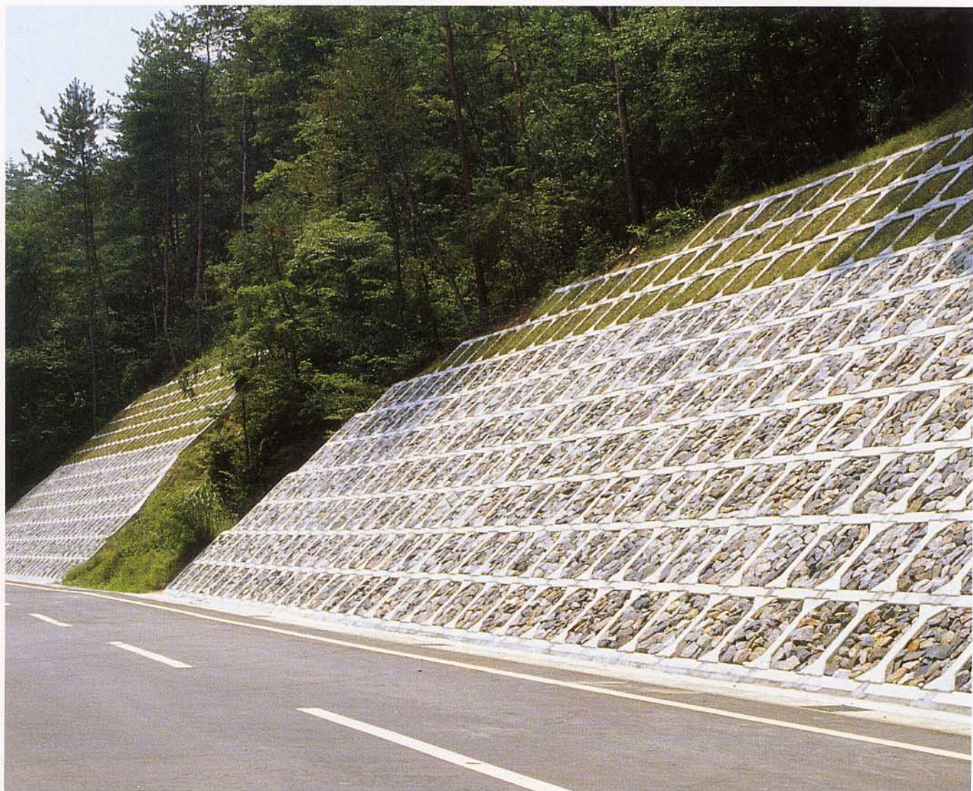
愛知県県道久木・中金線改良工事
