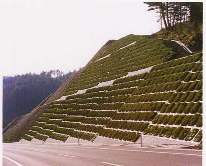
岩手県戸呂町軽米線道路改良工事
