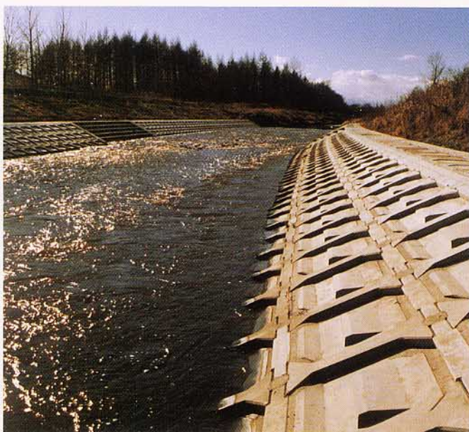
北海道売買川改修工事
