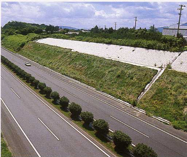
三重県伊勢自動車道工事
