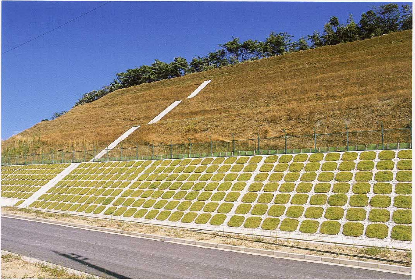
三重県大山田ニュータウン造成工事
