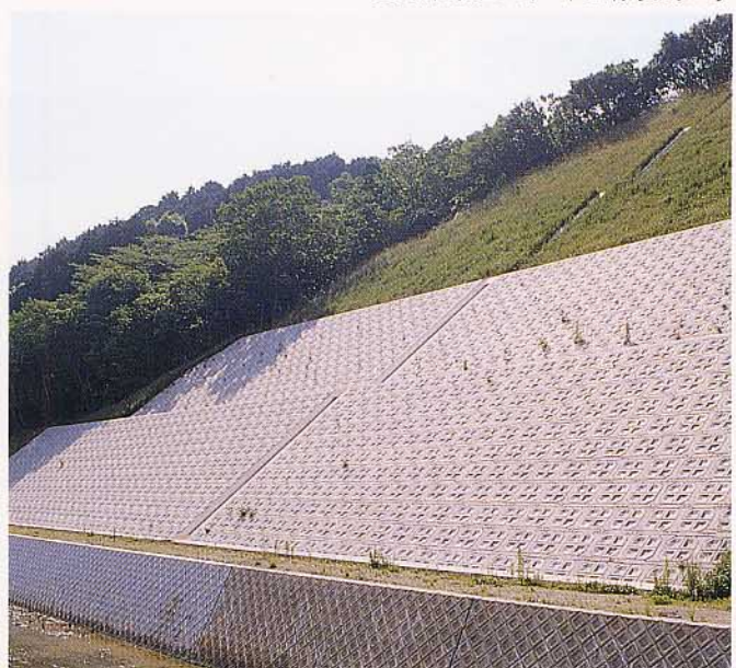
三重県鳥羽松阪線道路改良工事
