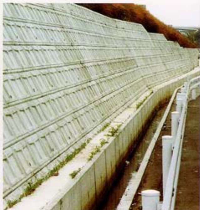
千葉県 東関東自動車道大管橋工事
