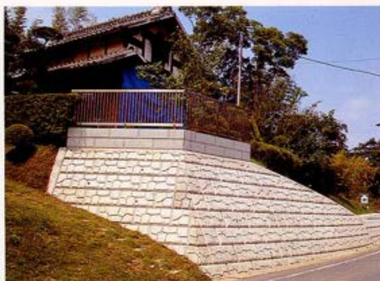
茨城県 黒川道路災害防除工事
