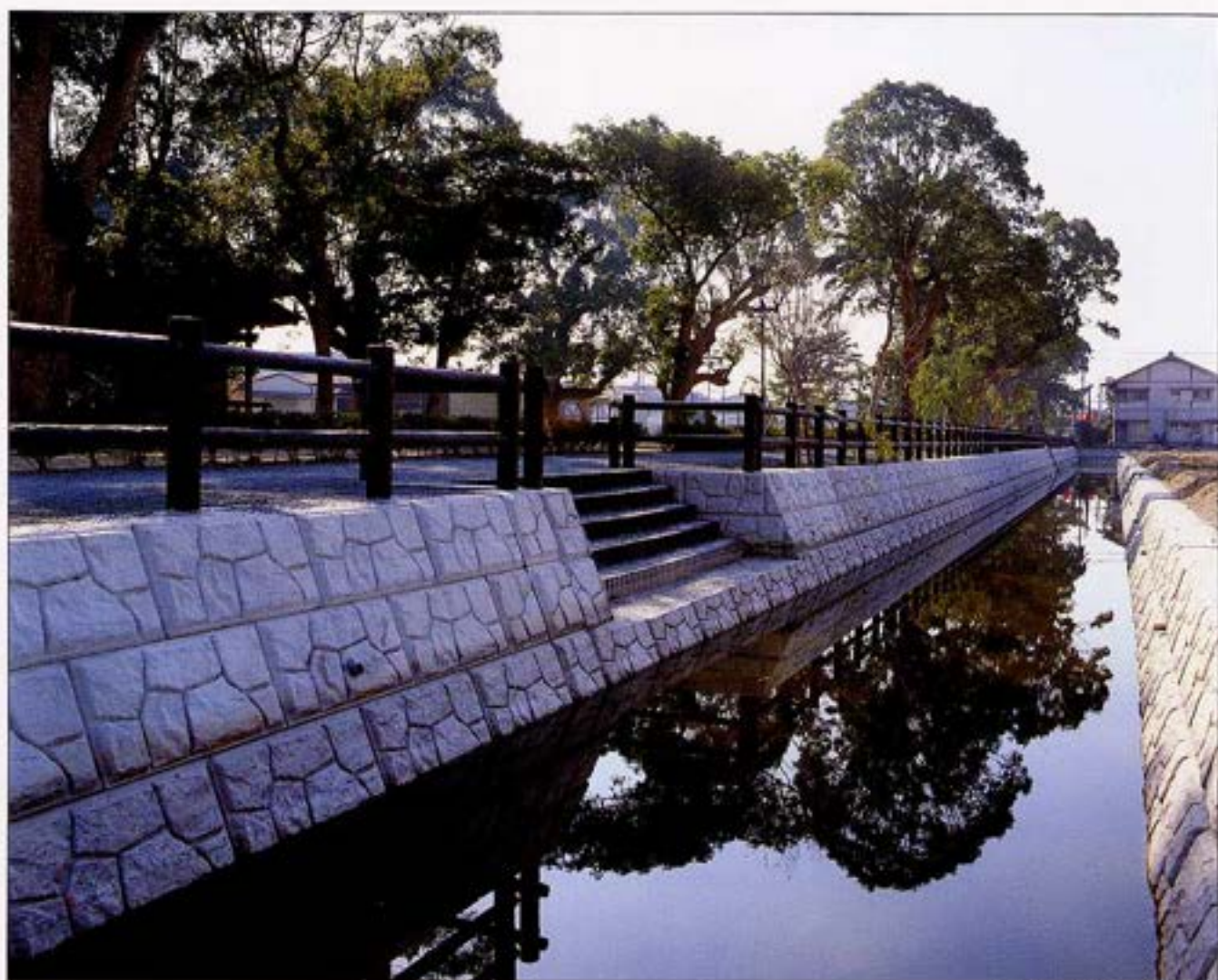
福岡県 農業排水施設工事
