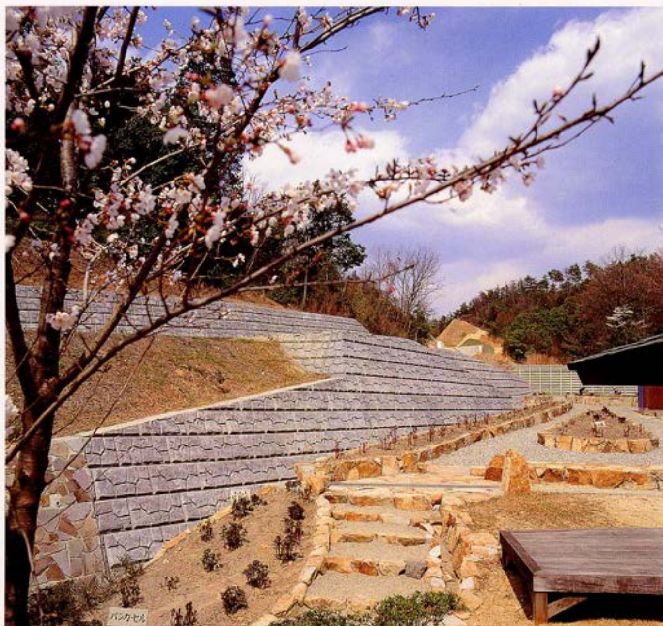
香川県 町道五毛線改良工事
