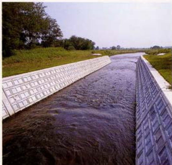
新潟県 滝川災害復旧工事
