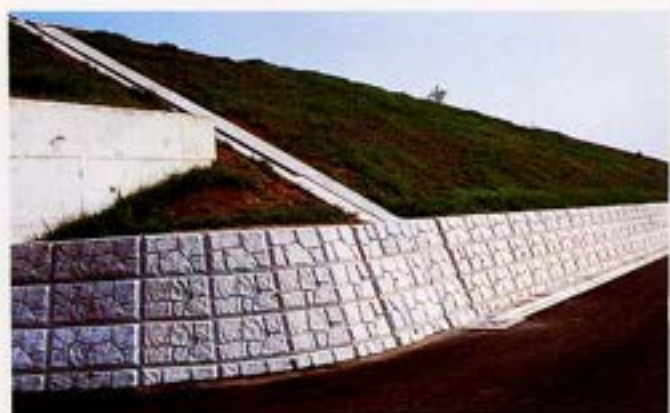
宮城県 仙台東道路工事
