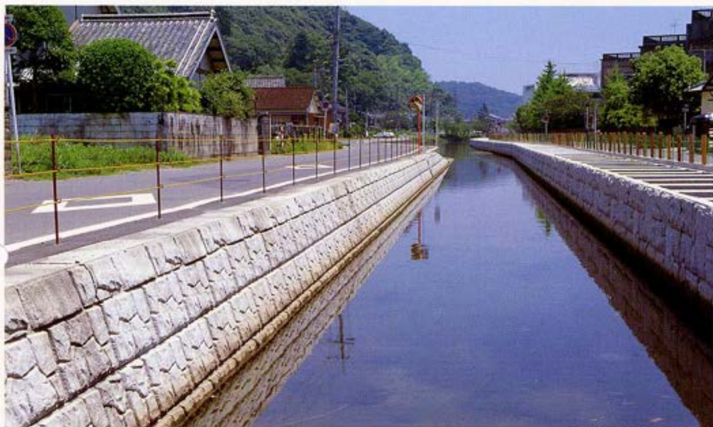
大分県 臼坪川下水道整備工事
