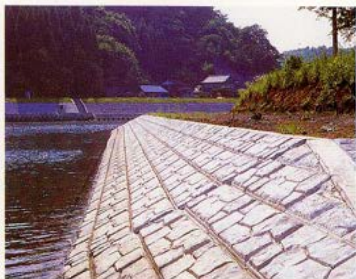
大分県 玉東川河川改修工事
