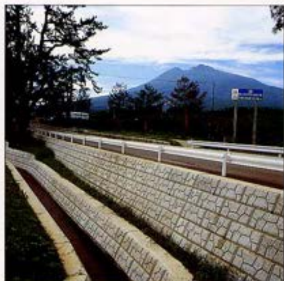
青森県 弘前線緑ヶ沢線道路環境美化対策工事
