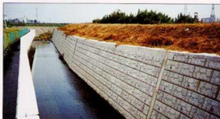
神奈川県 五ヶ村排水路施設工事
