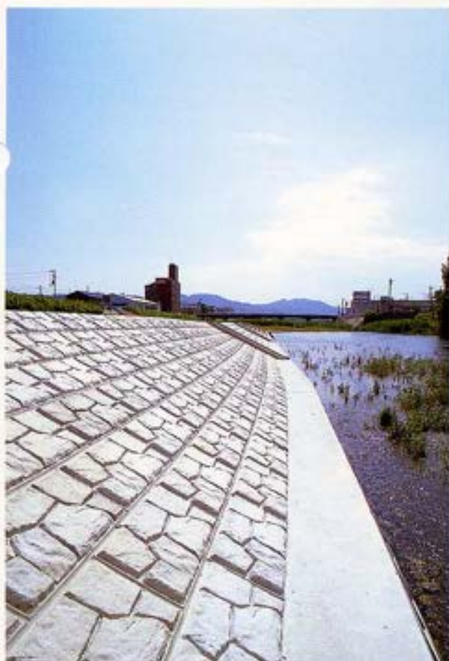
愛媛県 幡郡川滝浦環境整備工事
