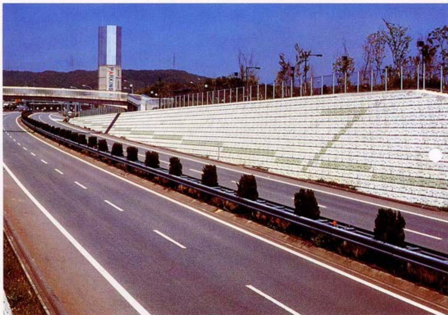
阪神高速北神戸線法面補修工事
