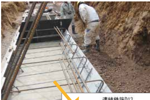
組立配筋設置
