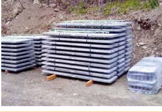
仮置き状況(壁面積70㎡分)
