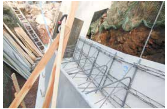
背面パネル設置
