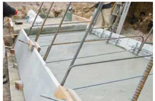
コンクリート投入後
