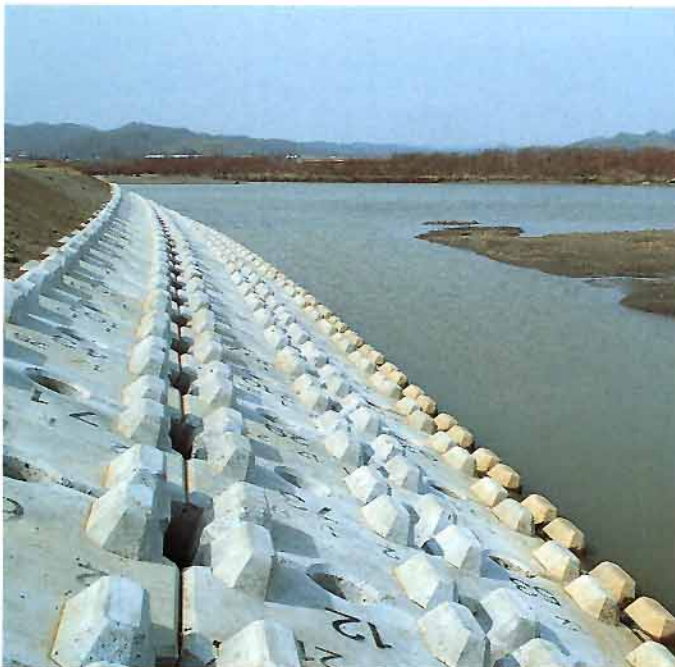
北海道 麻路川災害復旧工事
