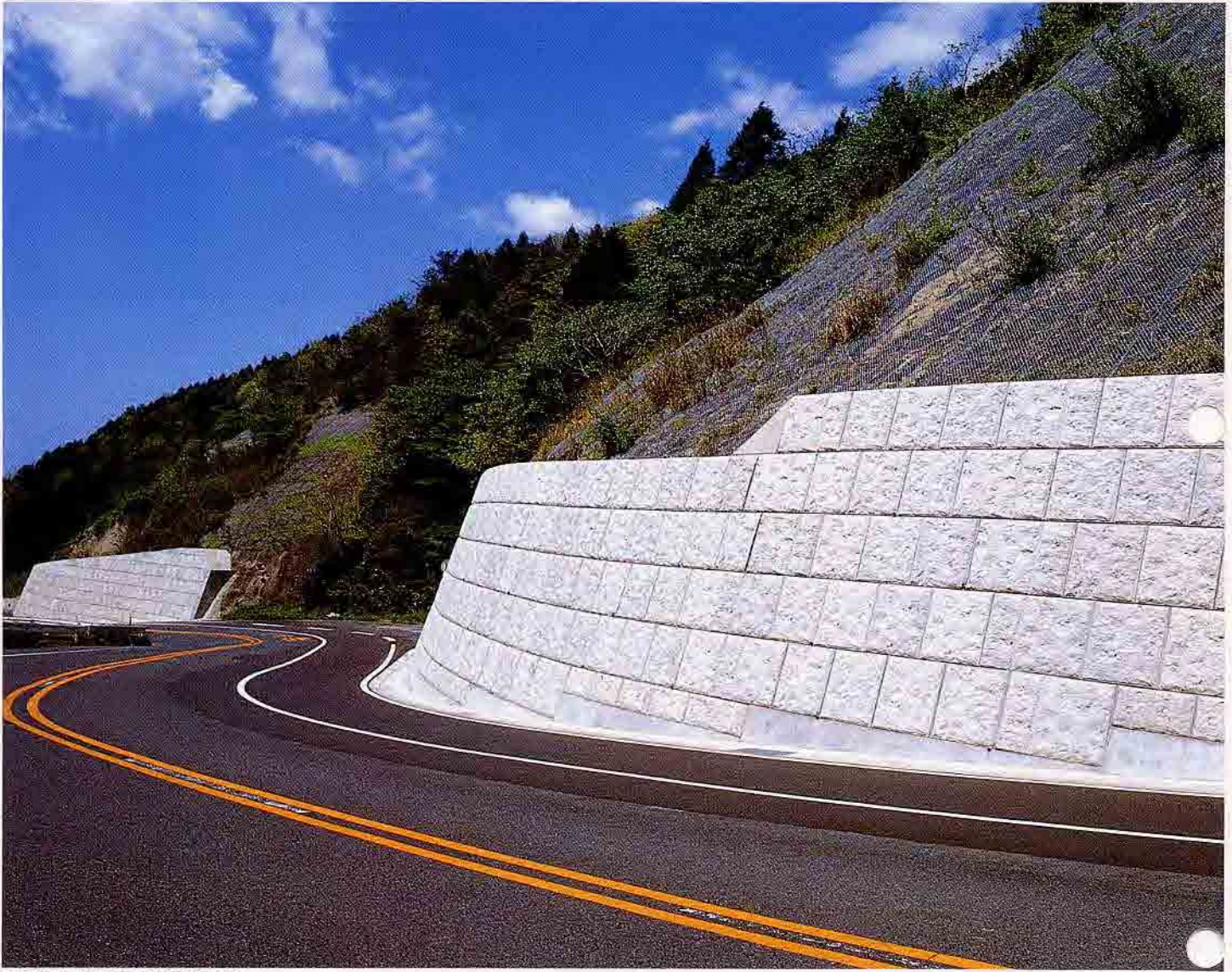
鹿児島県 緊急地方道路整備工事
