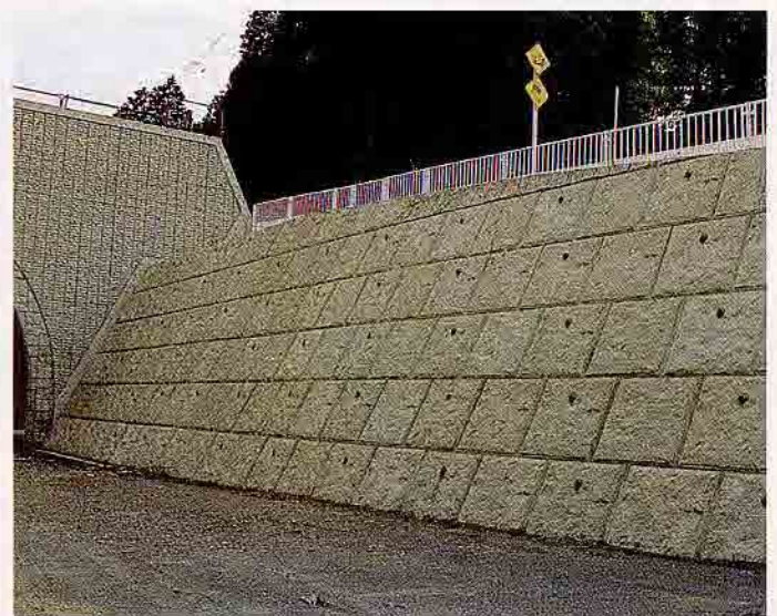
東京都 網代第一トンネル工事
