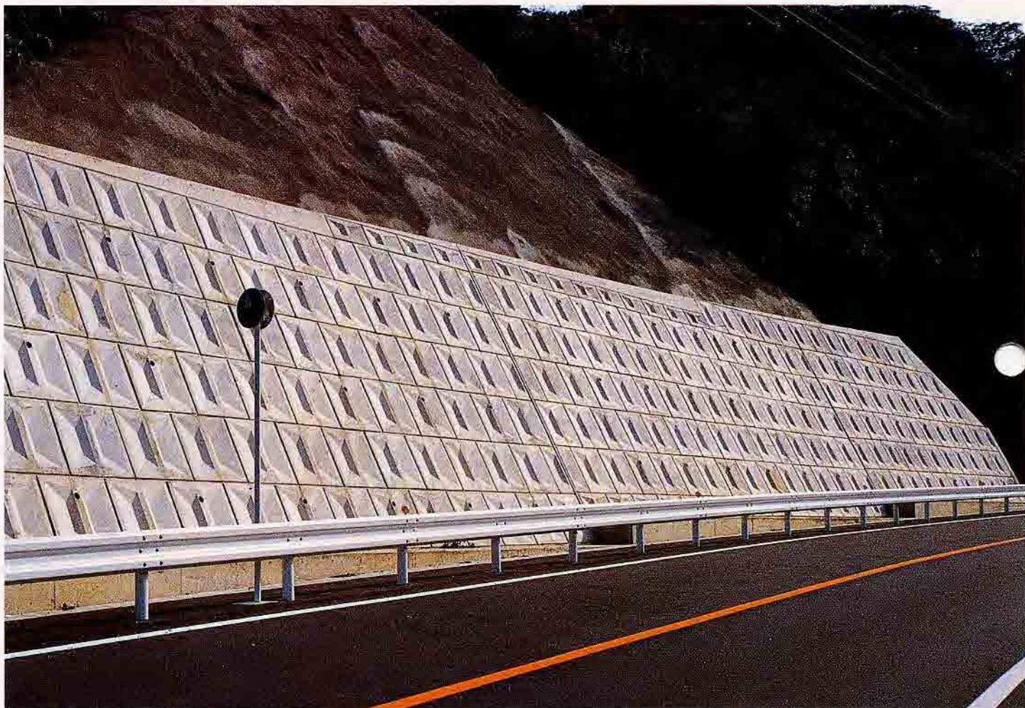
愛知県 交通安全対策事業公安改築工事
