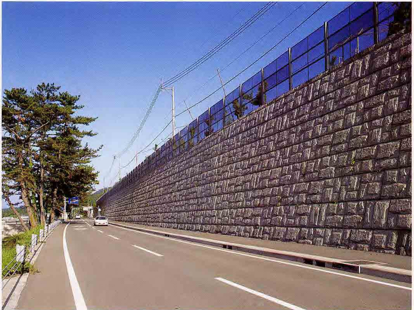
鹿児島県 県道桜島港～黒神線道路改良工事
