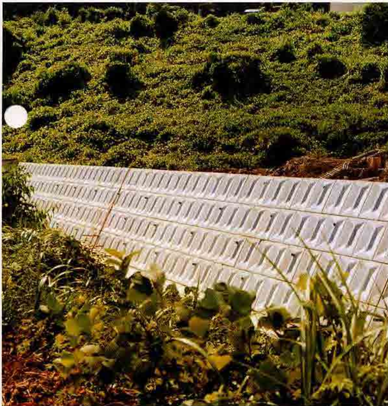
京都府 民間敷地造成工事
