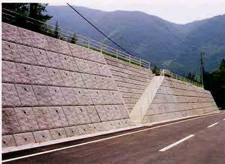
愛媛県 落合久万線ふるさとづくり関連道路整備工事
