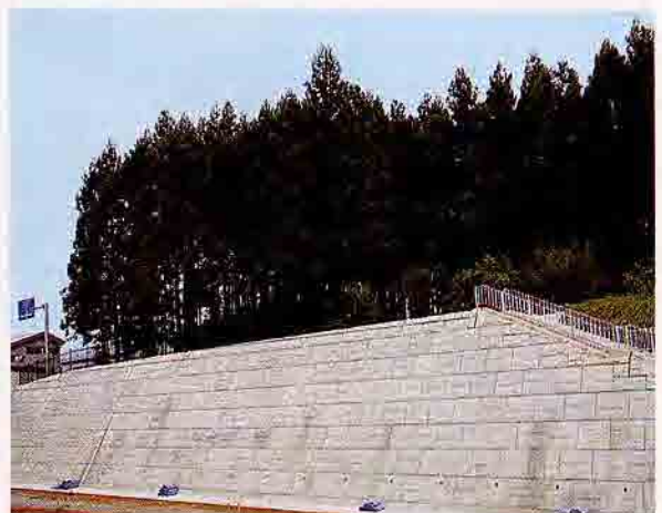
青森県 国道338号道路改良工事
