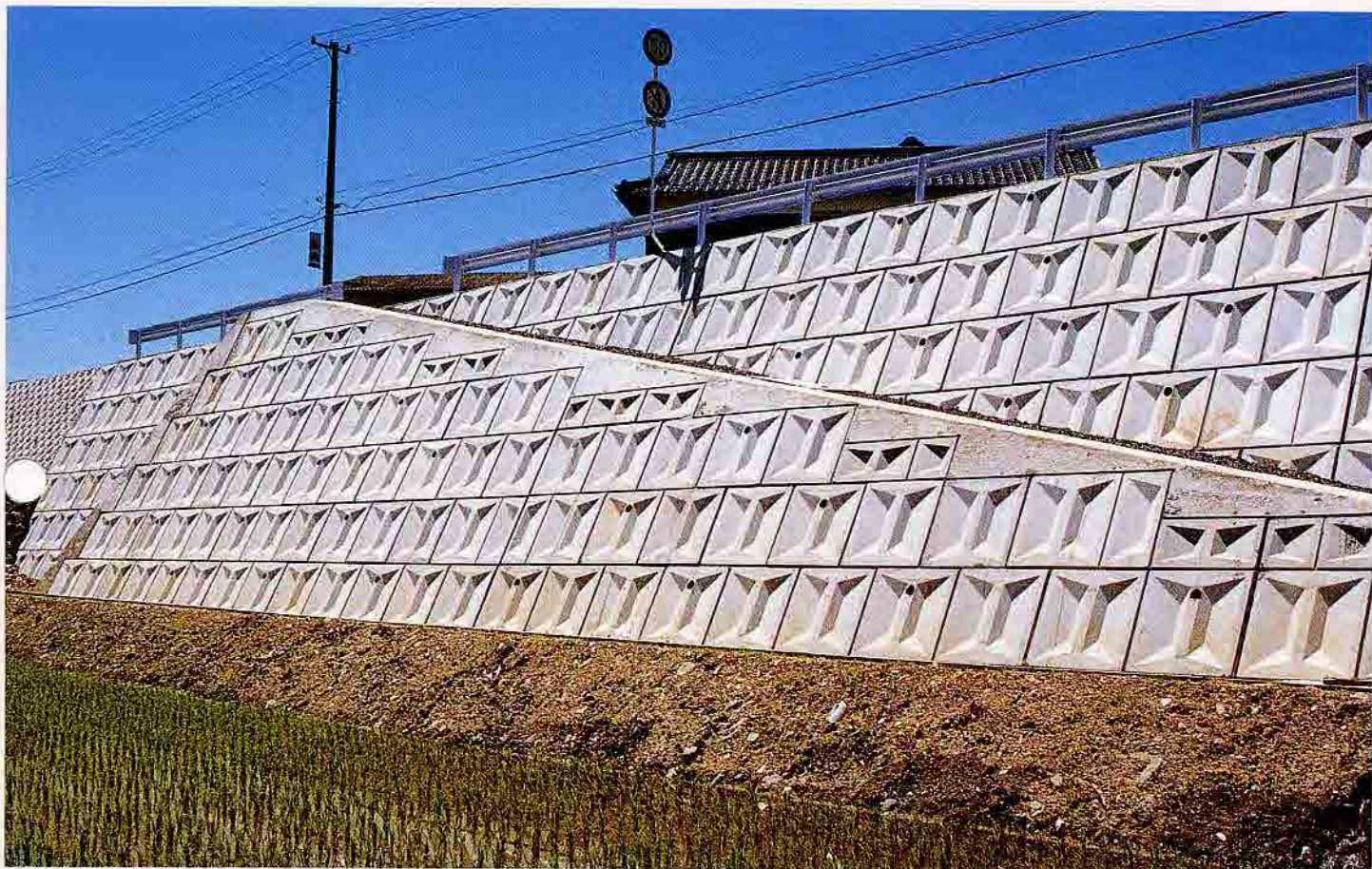
三重県 国道25号整備工事
