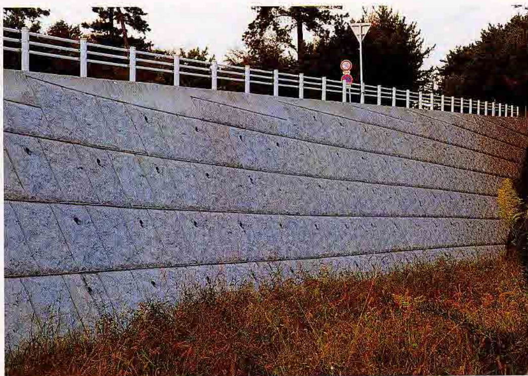
愛知県 大高緑地園路整備工事
