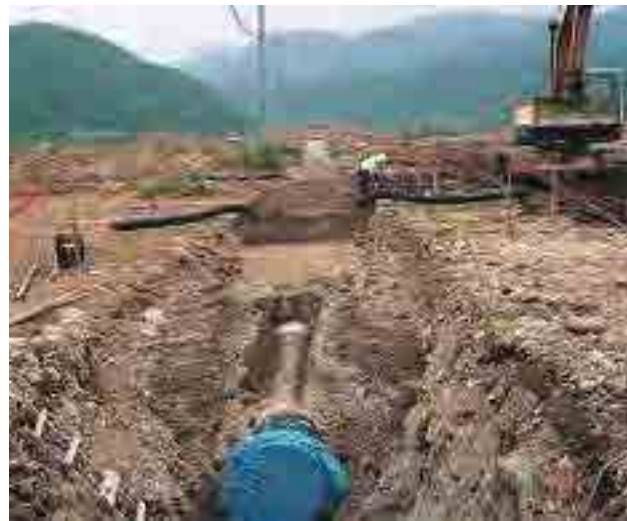
▲ 圃場整備小排水路管路化工事
