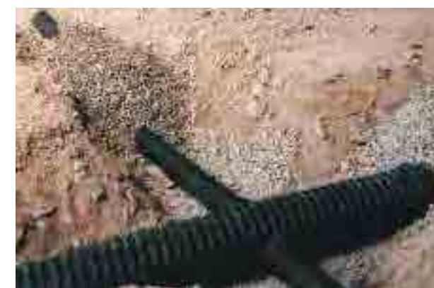
▲ トンネルセンタードレン
