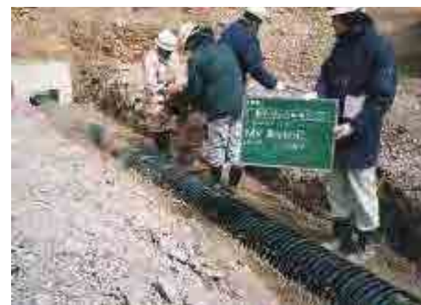
▲NEXCO用排水管工事
