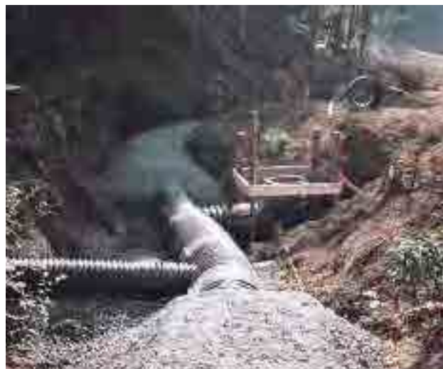
▲ 土捨場防災暗渠工事
