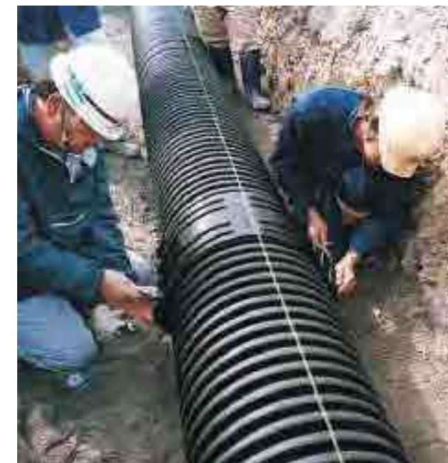
▲リング管ソケットの取付け
