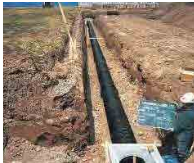
▲ 小排水路の管路化工事
