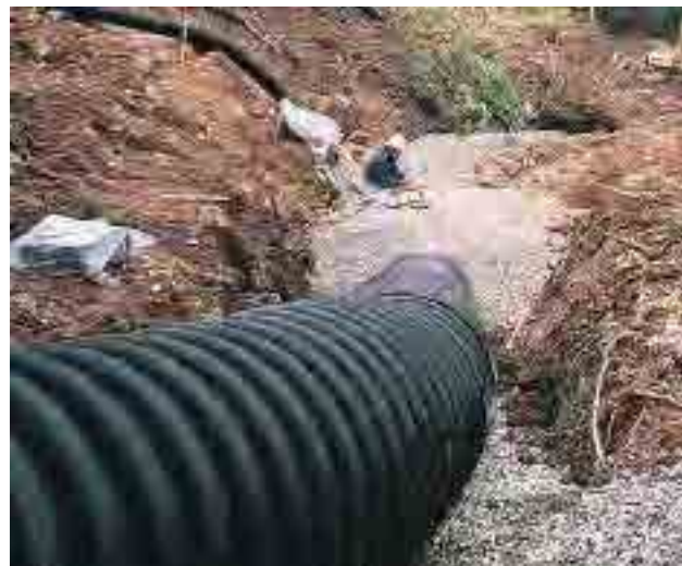
▲ 土地造成防災暗渠排水工事
