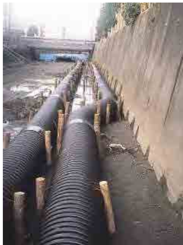
▲河川改修(水路切り回し)工事
