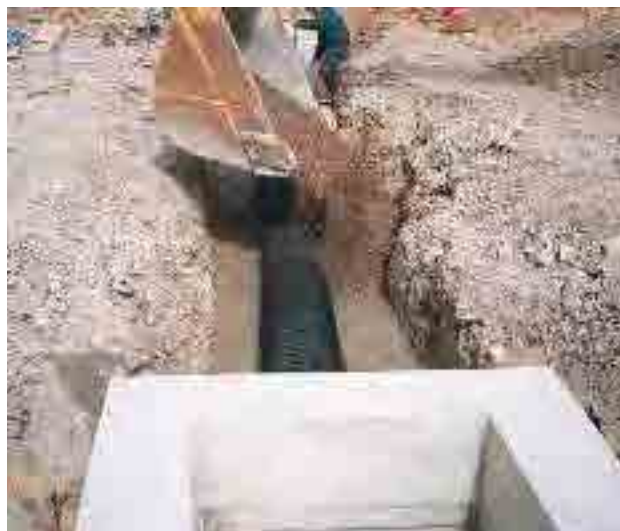
▲ NEXCO用排水管工事
