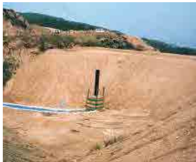
▲ 土地造成堅形集排水管工事
