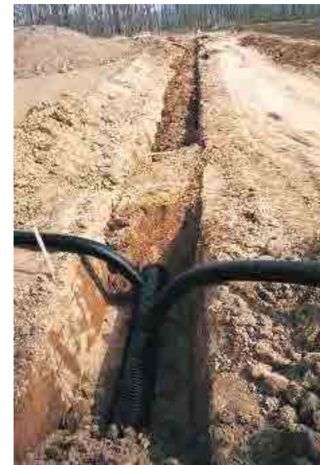
▲ 小排水路の管路化事業 排水枝管接続
