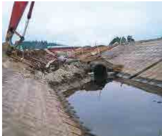
▲ 河川改修仮排水工事
