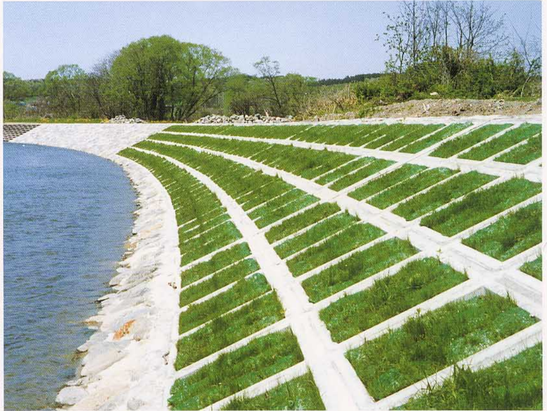
岩手県稗貫川筋亀ヶ森地区改修工事 (I型)
