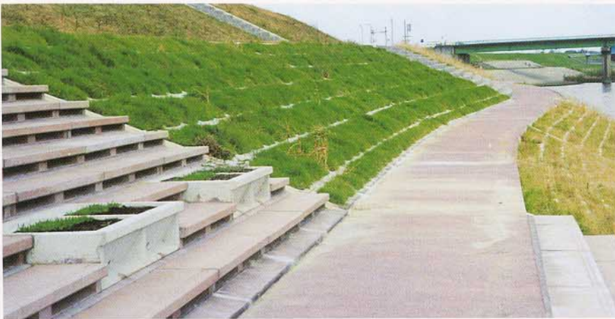
茨城県 戸田井高水護岸工事 (I型)
