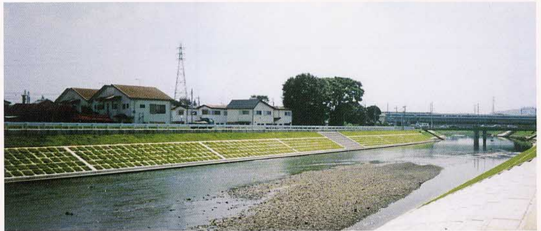
神奈川県 中小河川改修工事(公共)・鈴川 (II型)
