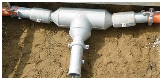
直埋T分岐方式（写真）
