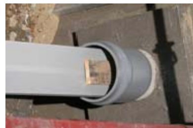
セパレータ移動防止治具を取り付けた状態
