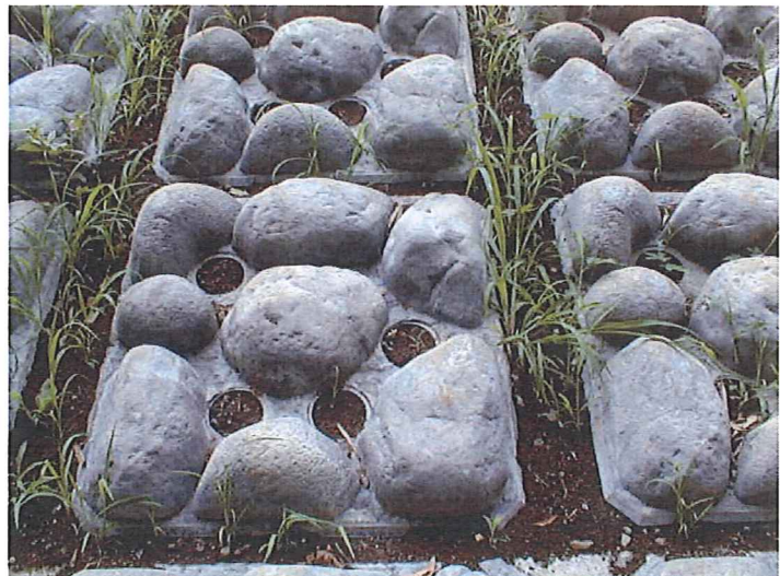
沼田土木事務所 入沢川砂防工事
