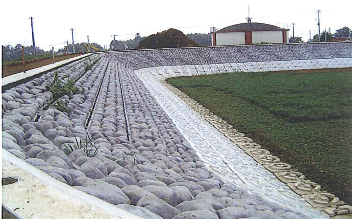
前橋市役所 荻窪地区開発整備事業（調整池）
