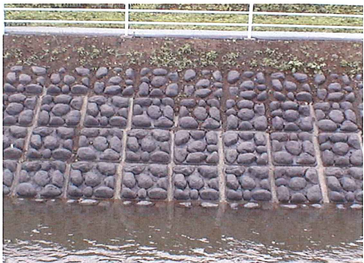
高崎土木事務所 井野川災害復旧工事
