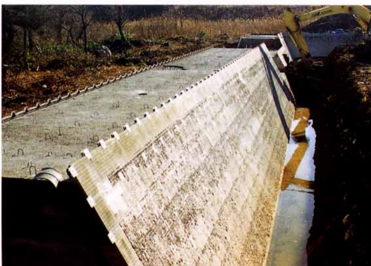
新潟県 新井砂防事務所 関山演習場障害防止対策砂防工事
