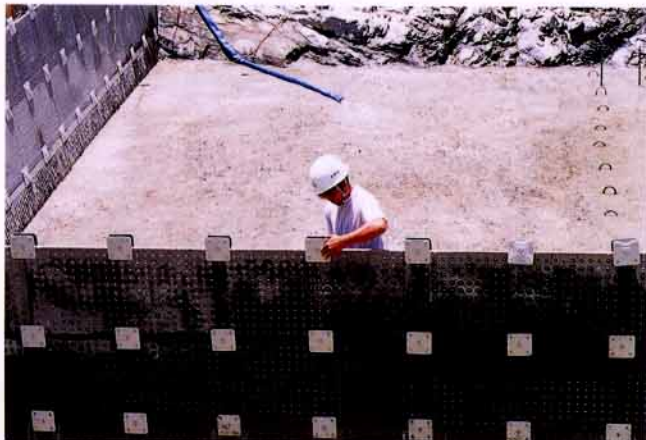
1 組立 プレート取付
