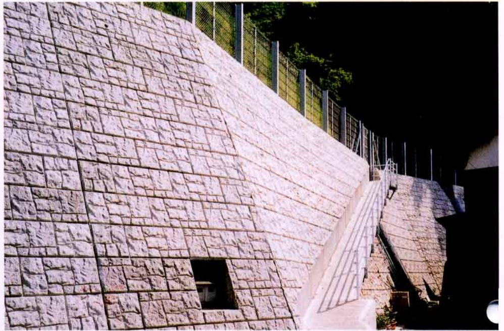
福井県 朝日土木事務所 急傾斜地対策工事
