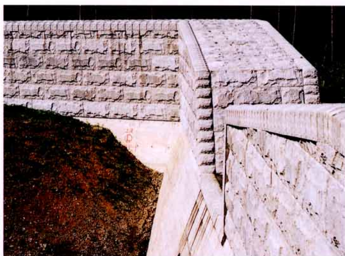
神奈川県 平塚土木事務所 尻無堰堤砂防工事
