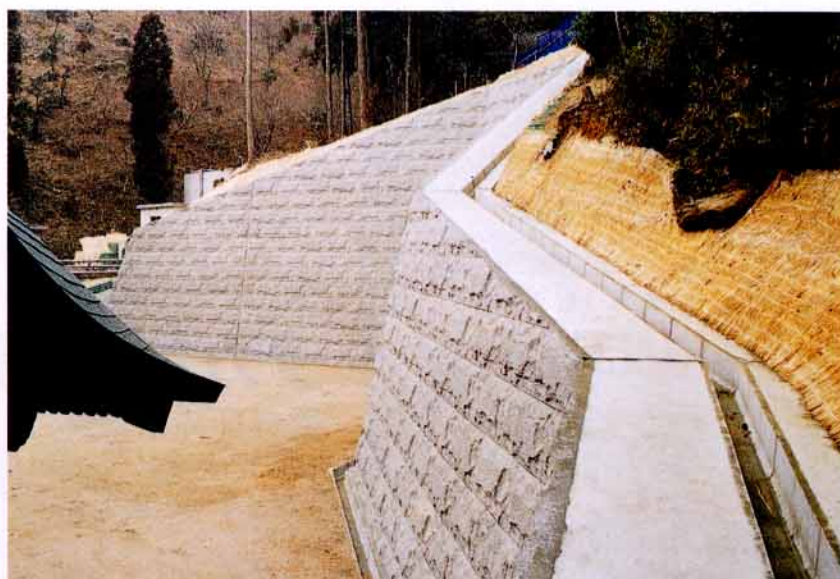
福岡県 大本山瀧光徳寺 御宝蔵土留擁壁工事
