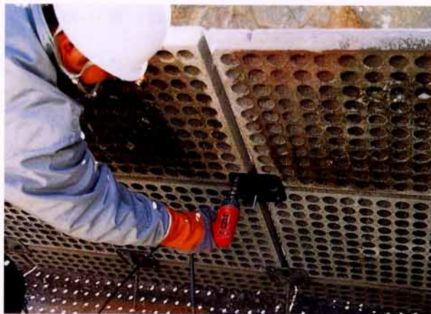
2 組立 ビアス連結締め付け
