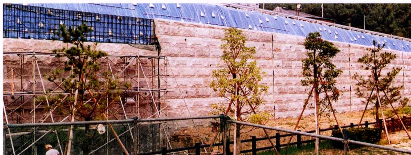
石川県 北陸地建 金沢工事事務所 庵道路防災工事
