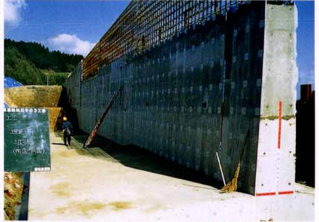
石川県 北陸地建 金沢工事事務所 庵道路防災工事
