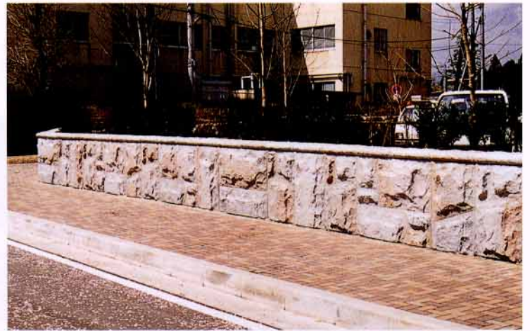
静岡県 御殿場市 御殿場中学外溝工事
