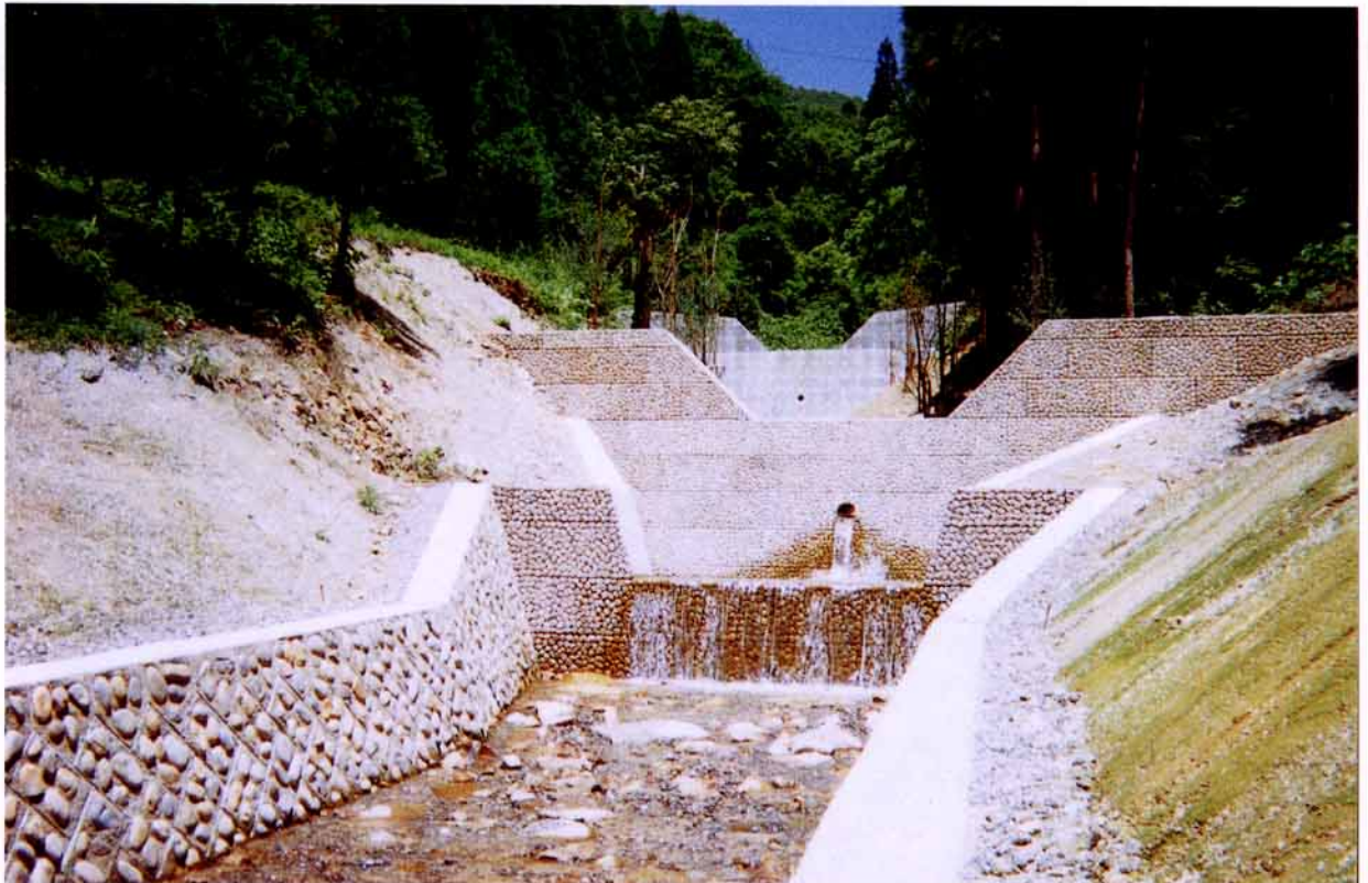
岐阜県 高山山林事業所 災害関連緊急治山事業工事 8598号
