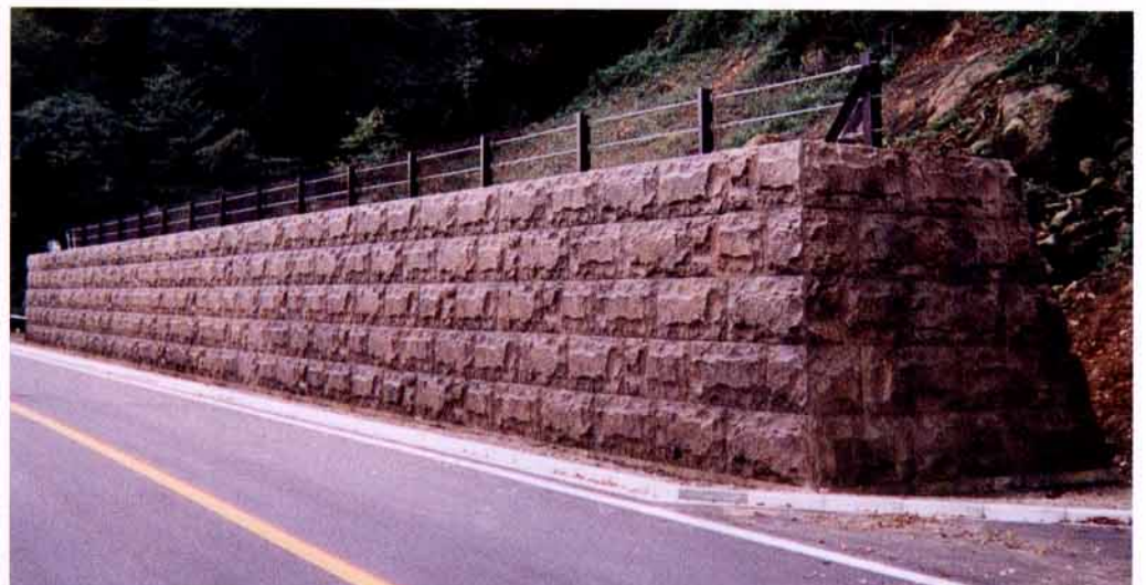
群馬県 富岡土木事務所 一般県道上小坂四ツ家妙義線
