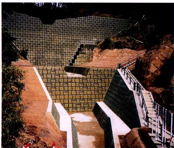
山形県 庄内支庁 船見沢砂防工事（飛島）
