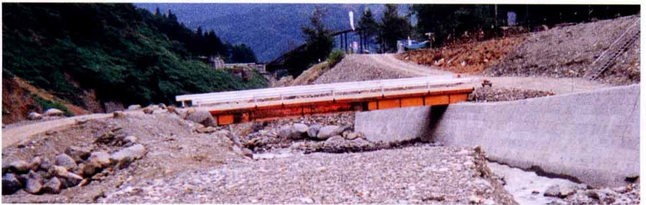
長野県 北陸地建 松本砂防 浦川第8号砂防ダム
