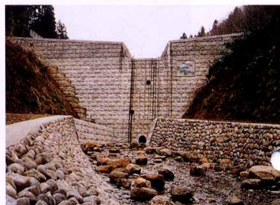
新潟県 三条土木事務所 いちのさわ川通常砂防工事
