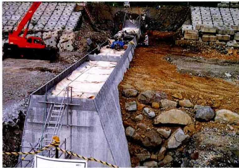
長野県 北陸地建 松本砂防工事事務所 来馬河原遊砂地7号帯工工事
