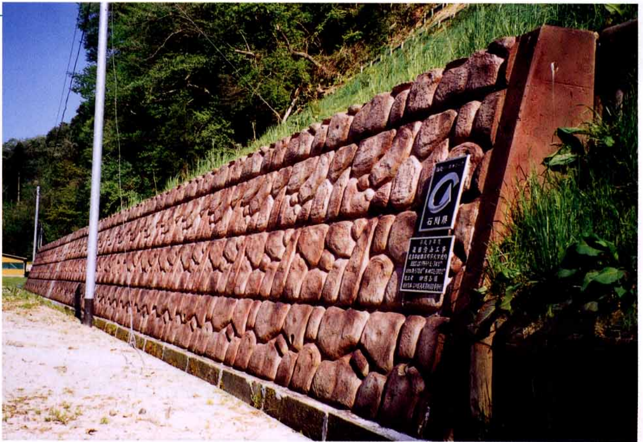
石川県 七尾農林事務所 大津地内復旧治山工事
