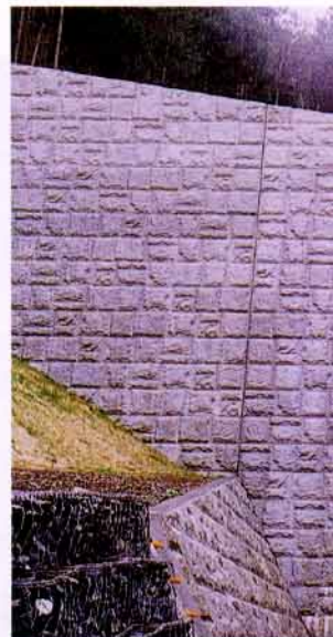
岩手県 釜石土木事務所 屋敷の沢筋屋敷地区 都市対策砂防工事
