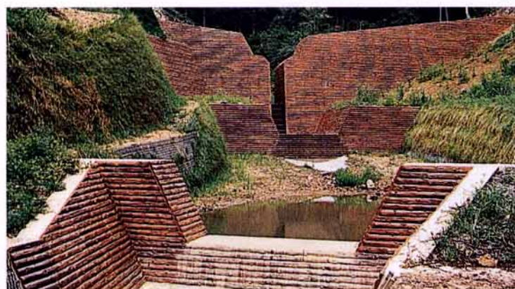
山形県 新庄建設事務所 三左工門沢荒廃砂防工事
