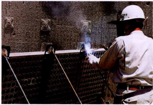
3 組立 セバレーター溶接 (溶接長10m/m以上)
