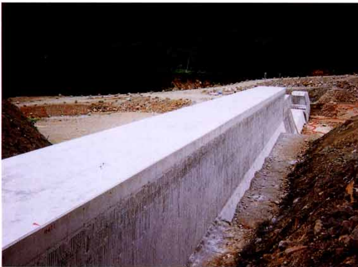
富山県 北陸地建 立山砂防工事事務所 湯川12砂防ダム
