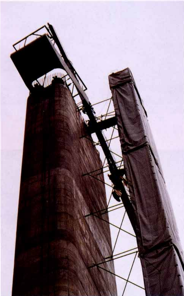
山形県 山形自動車道橋台工事 日本道路公団
