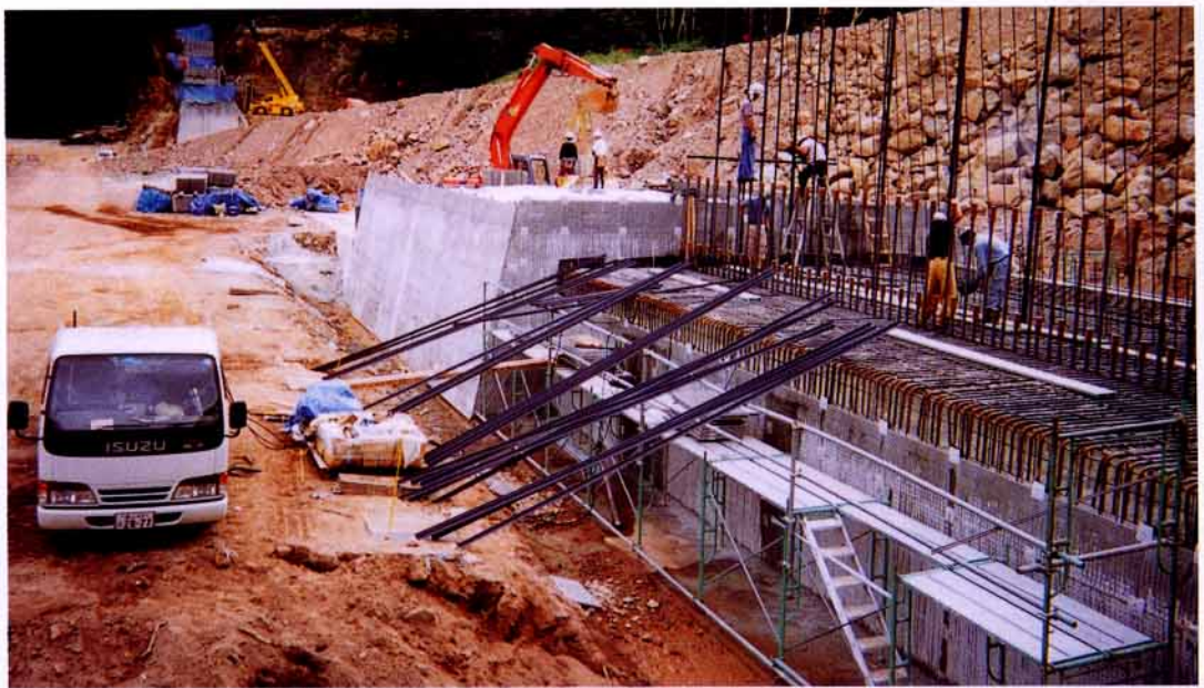
富山県 北陸地建 立山砂防工事事務所 うさぎ谷砂防工事
