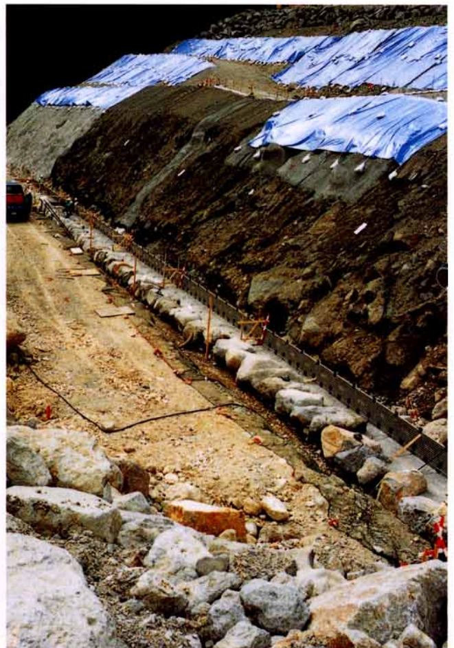
富山県 北陸地建 立山砂防工事事務所 第3号砂防ダム下流護岸工事
