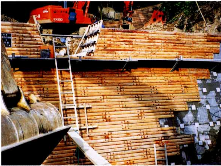
岐阜県 高山山林事業所 災害関連緊急治山事業工事 594号
