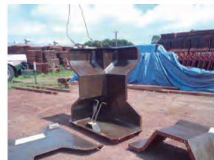
② 側板組み立て
