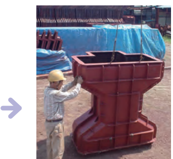
⑥ 型枠・ボルト点検調整
