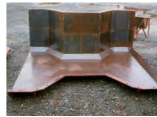
② 側板組み立て
