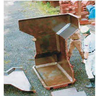
⑤ 型枠・ボルト点検調整
