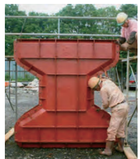
⑥ 型枠・ボルト点検調整
