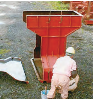
③ 側板組み立て
