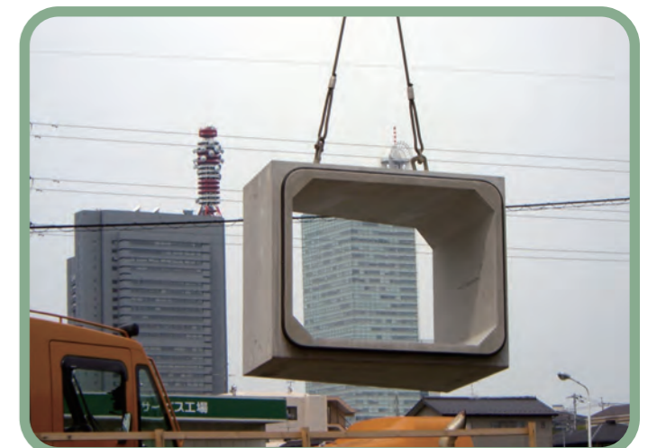
施主：さいたま市 工事名：芝川右岸第1排水区下水道工事 サイズ：2000×1500(幅×高さ)
