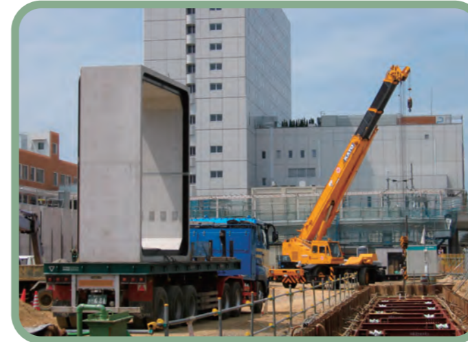
施主：豊橋市 工事名：管渠施設改良工事 サイズ：3500×4000(幅×高さ)
