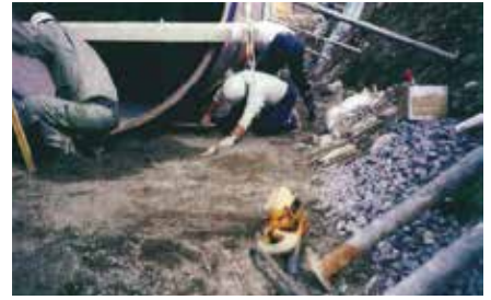
φ2600福井県共同事業 管底側部の締固め
