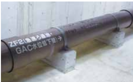
φ500大阪府浄水場内配管 コンクリートサドル+鋼製バンドで固定
