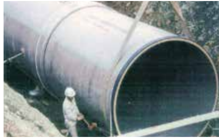
φ2600福井県共同事業 管接合状況
