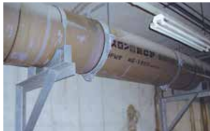
φ500大阪府浄水場内配管 支持金具で吊配管
