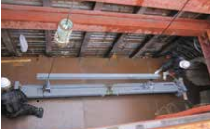
φ1000山口県工業用水道配水管 管路更生 カゴ型台車の吊り降ろし
