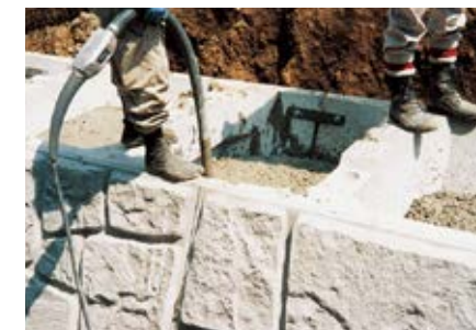
胴込めコンクリートの締め固め
