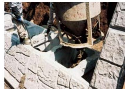
胴込めコンクリートの打設
