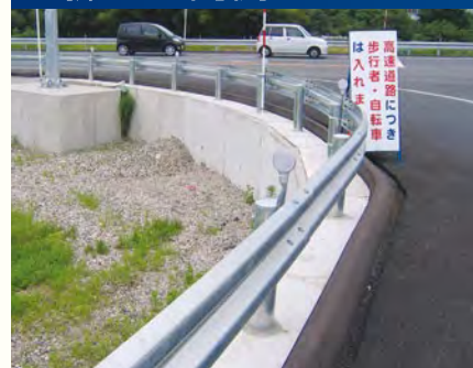
羽越河川国道事務所(新潟県)
