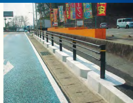
多治見砂防国道事務所(岐阜県)
