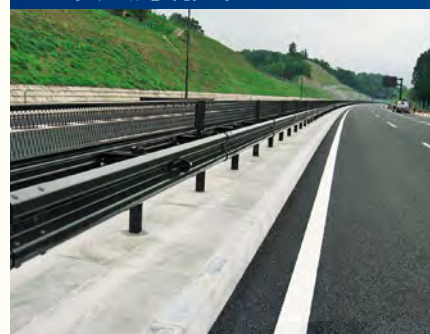
沼津河川国道事務所(静岡県)
