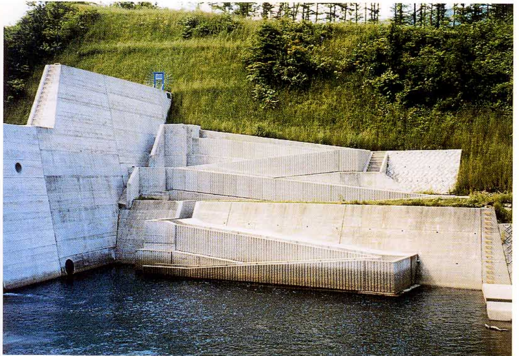
瀬の沢川筋瀬の沢砂防堰堤(魚道工)工事
