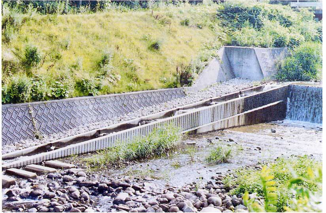
鹿ノ又川魚道設置工事
