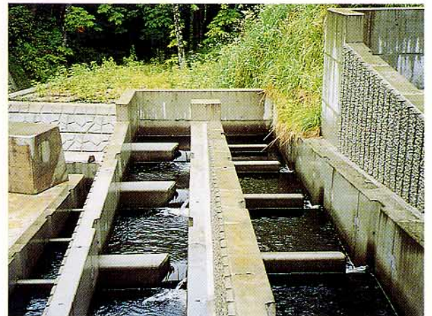
普代川筋細沢地区砂防堰堤(魚道工)工事
