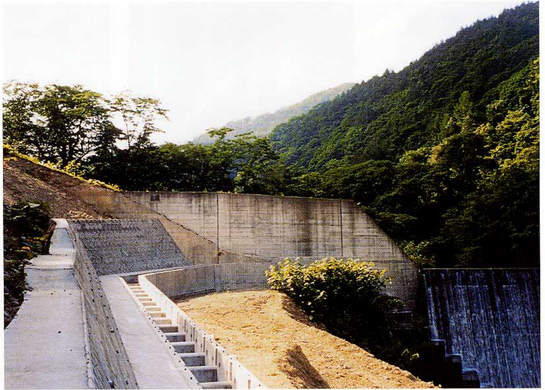
瀬の沢川筋瀬の沢砂防堰堤(魚道工)工事
