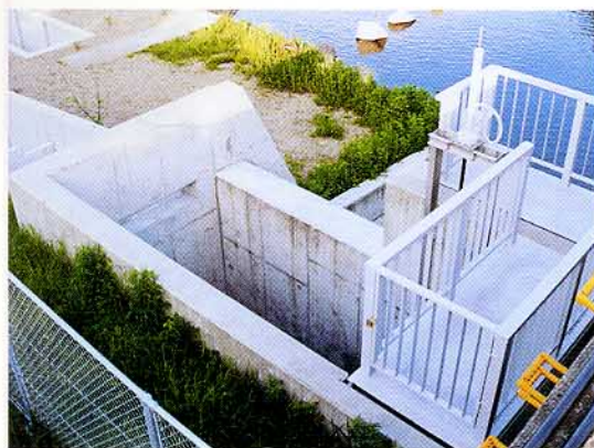
永沢川筋細野堰堤魚道工事
