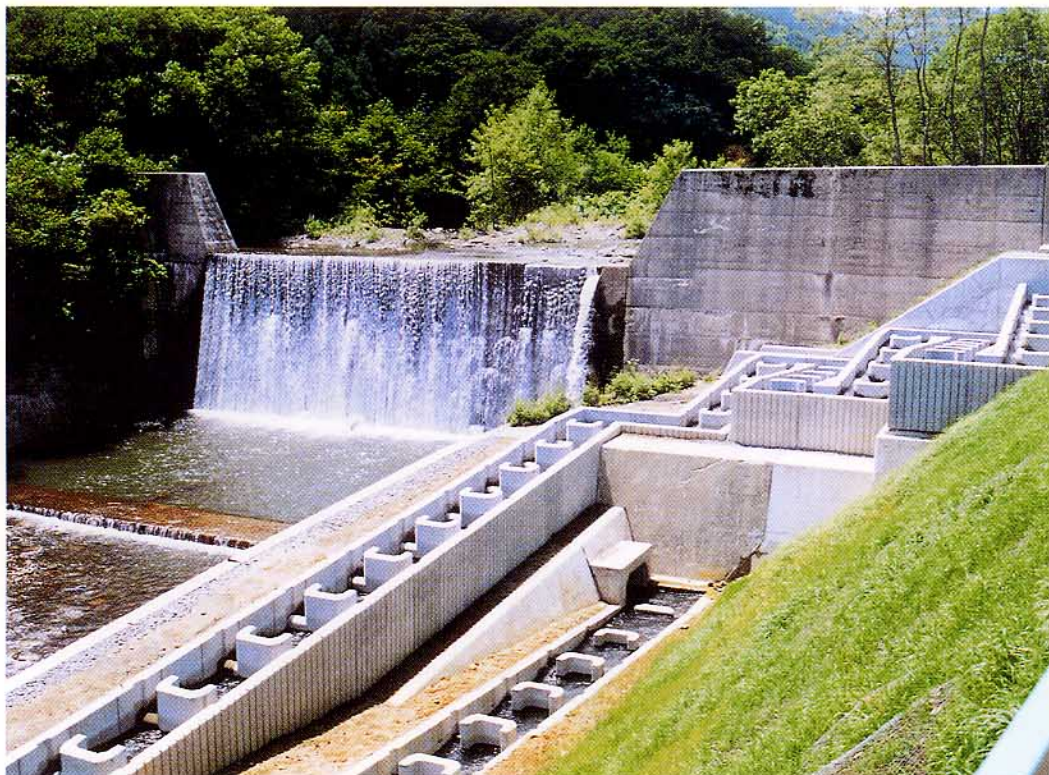
キッツ川筋下大森地区砂防堰堤魚道工事
