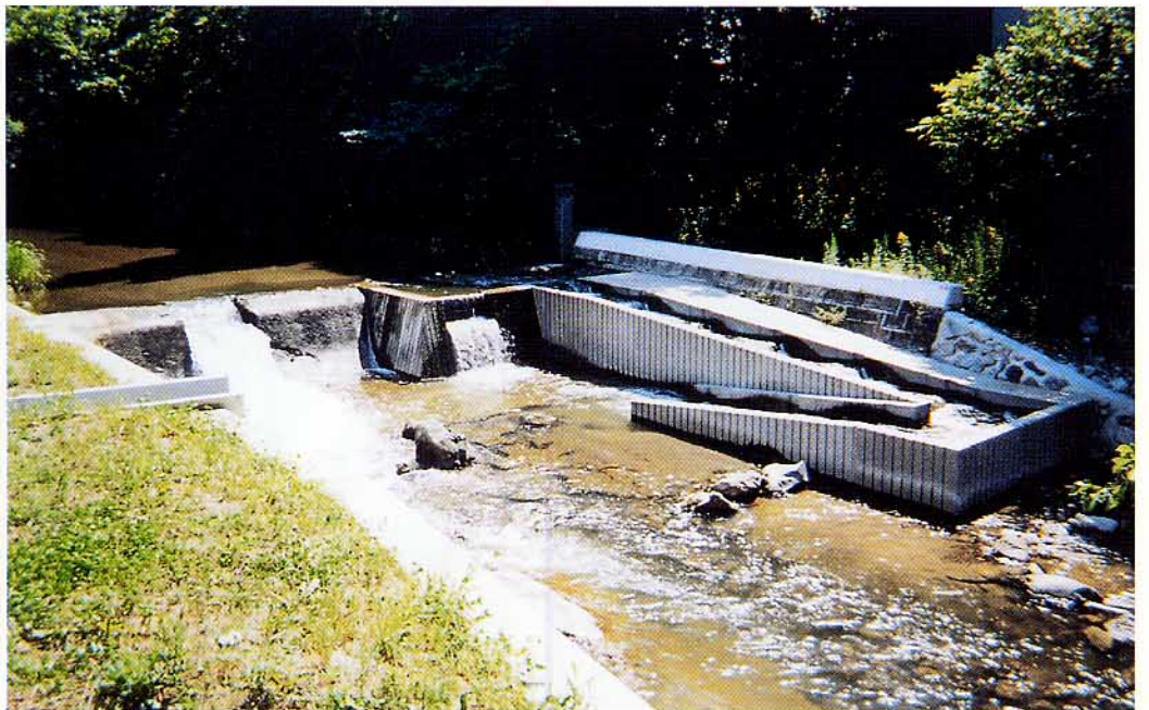
宮守川筋宮守地区護岸工事
