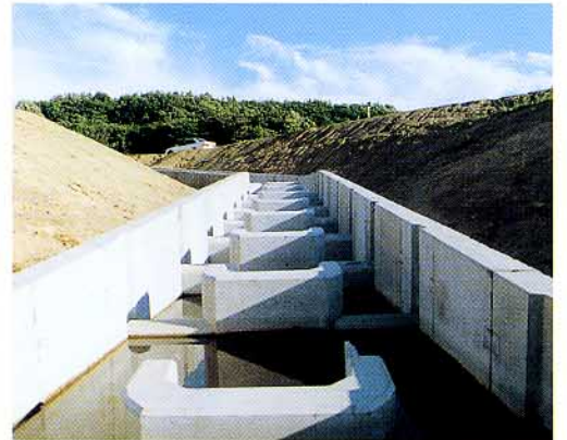
桧木川砂防整備工事
