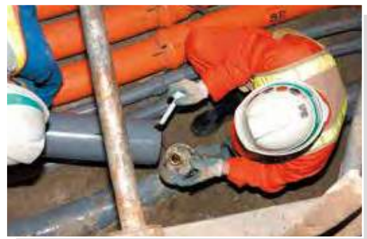
■ 通信ケーブル保護管に滑剤を塗り接合
