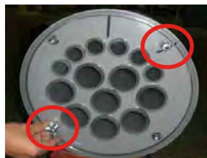
ダミー管固定板取付け
