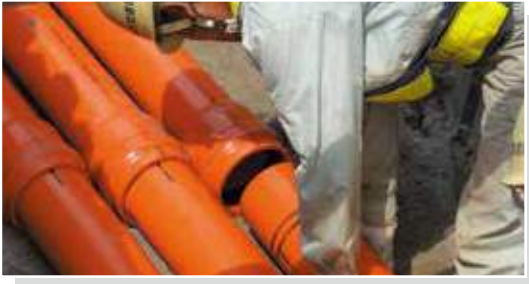
■ 電力ケーブル保護管に滑剤を塗り接合
