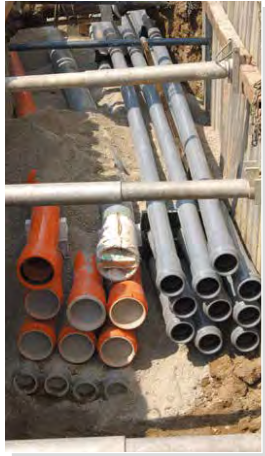
■ ケーブル保護管の多条布設
