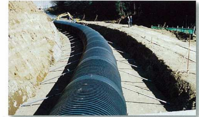
継手部による不同沈下への追従例
