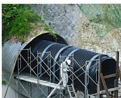
コルゲート管更生工事
