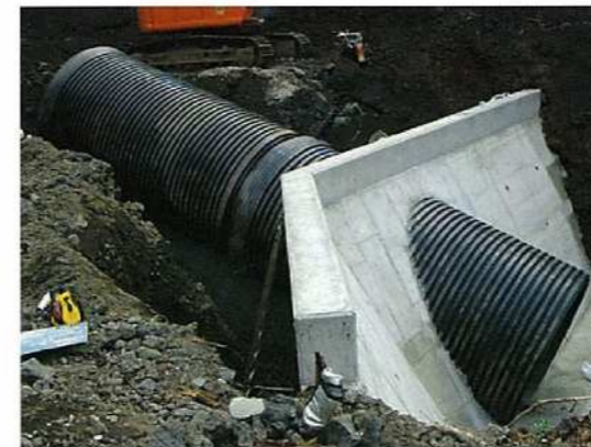
大口径φ2400 急傾斜地配管
