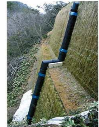
急傾斜露出配管
