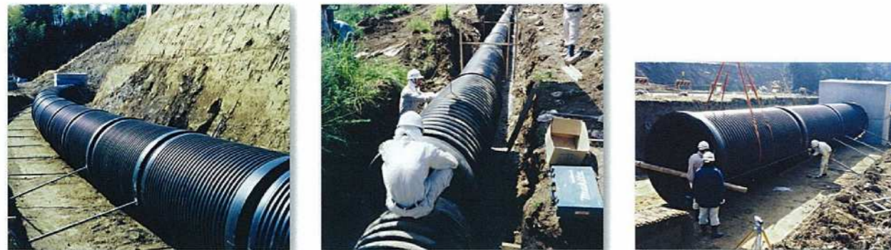
①基礎コンクリート不要。②1本5mの長尺。③粗度係数0.01の為、口径のスケールダウン。
