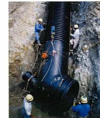
水力発電施設からの放流管
