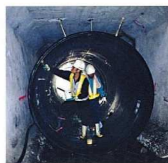
ボックスカルバート更生工事
