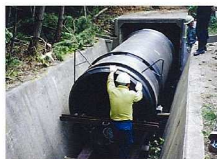
管更生工事 挿入状況
