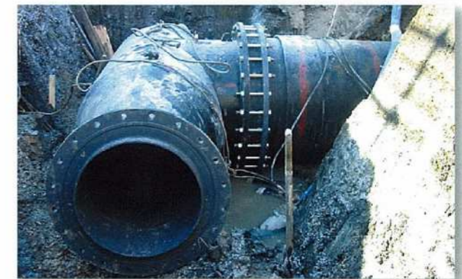
フランジ継手への加工品 (鋼管との接続)
