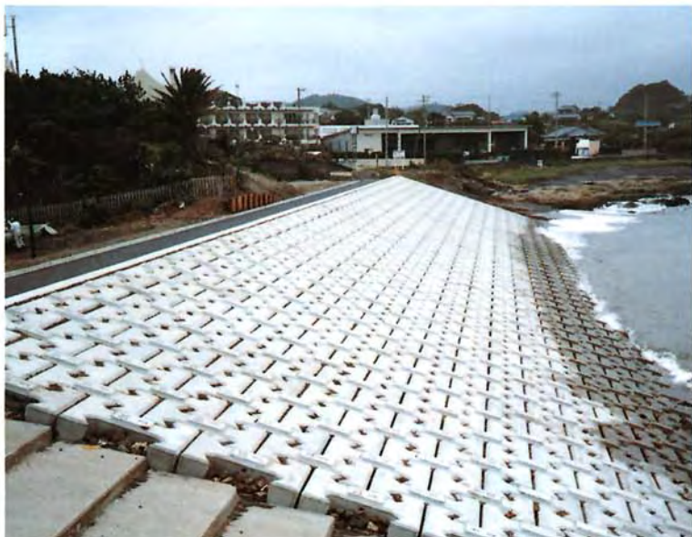
千葉県千倉海岸災害復旧工事
