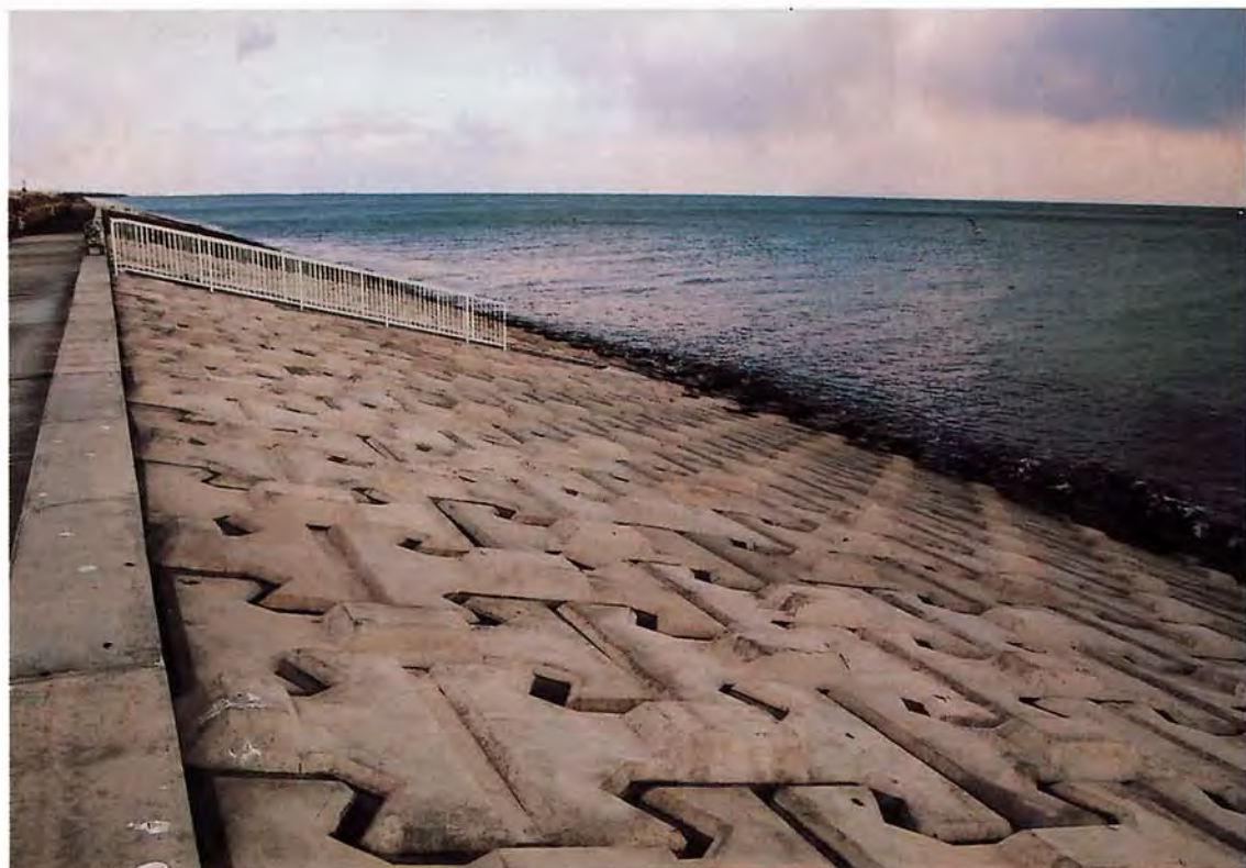
北海道白老海岸災害助成工事
