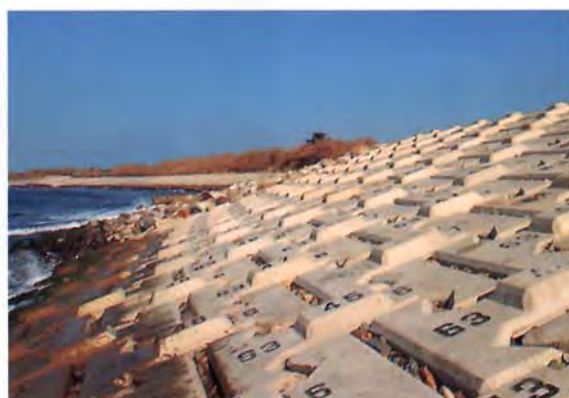
鳥取県中山海岸災害復旧工事
