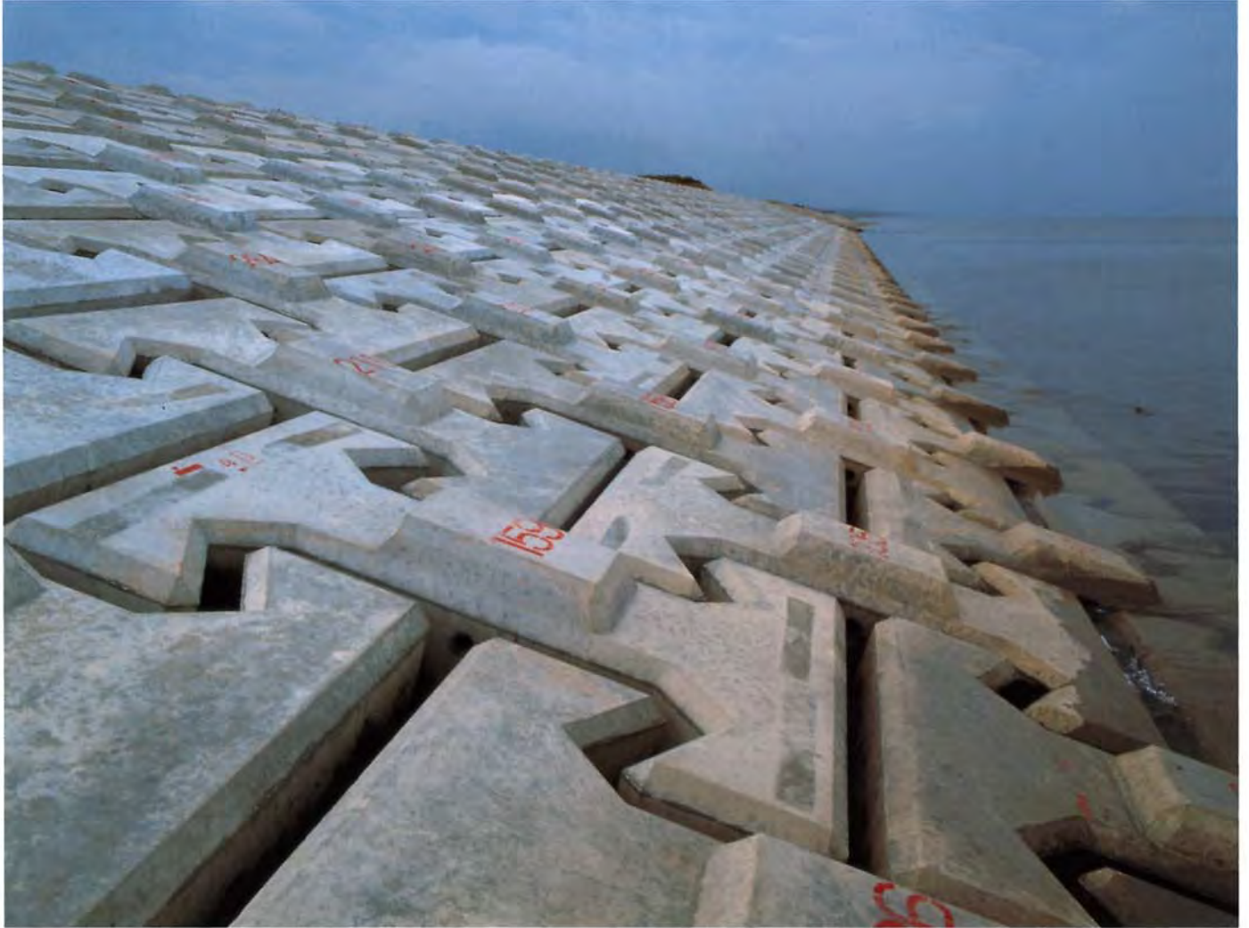
青森県雲雀平海岸災害復旧工事
