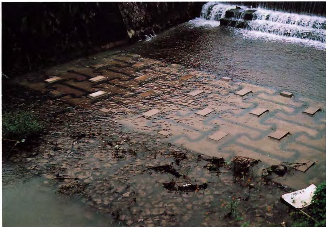
大阪府茨木川改修工事
