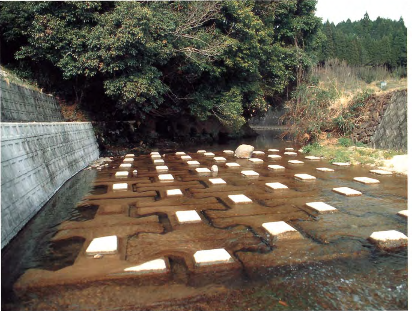
熊本県永野川河川工作物工事
