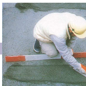
3 モルタル敷設
