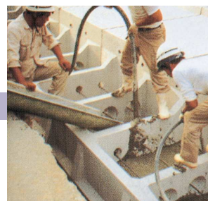
6 間詰めコンクリート打設(鉄筋挿入)
