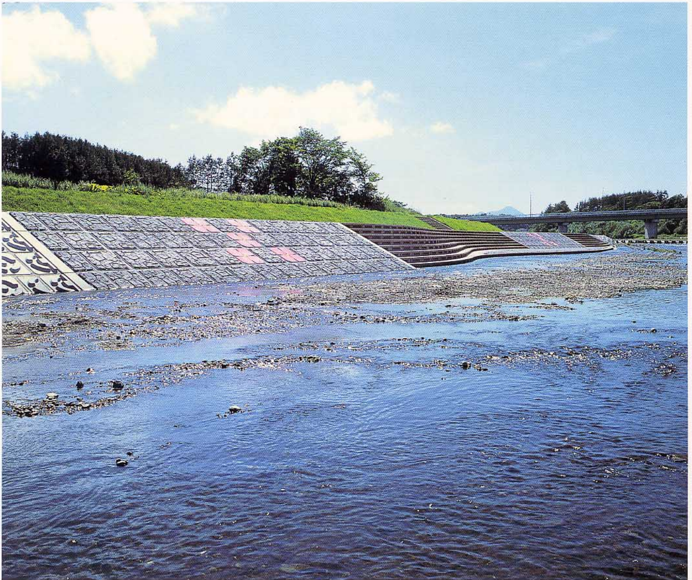
北海道 鑑別川局部改良工事
