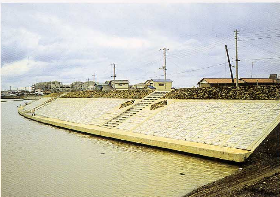
神奈川県 金目川改修工事
