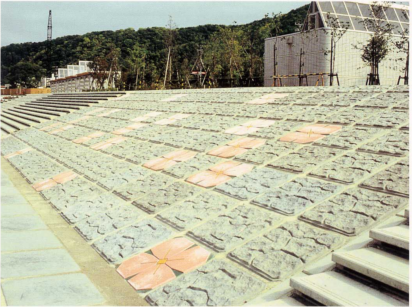
北海道 網走川改修工事
