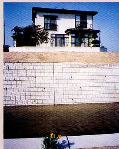
岩手県茂井羅南堰排水路工事
