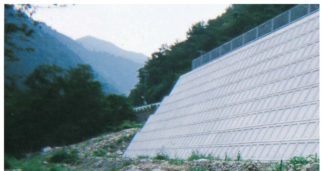
山間部の路側での使用例 [壁前面は河川、天端は道路]
