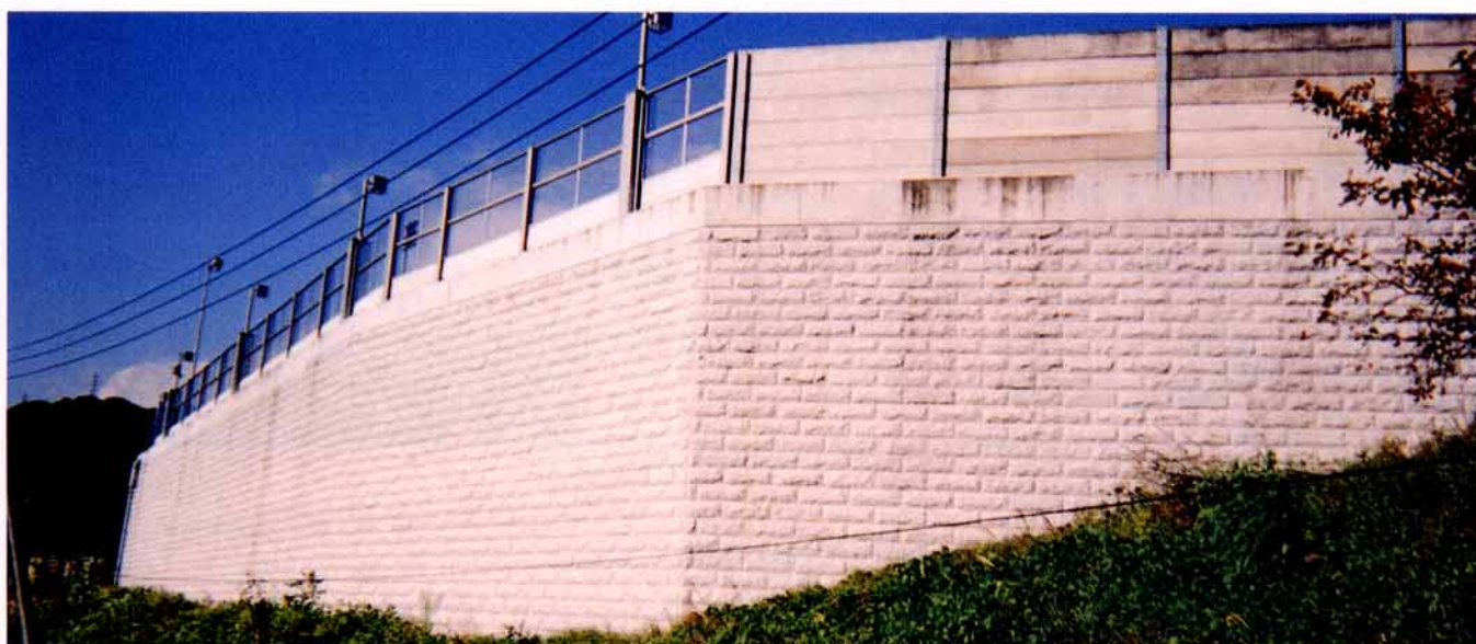
中央自動車道 藤野P.A修景工事（日本道路公団）
