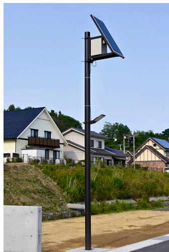
DJ (電柱共架)
