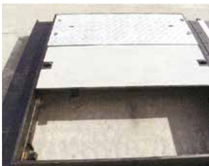
7 残った蓋を同様に開閉バールにて持ち上げる
