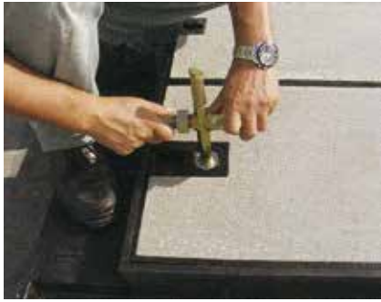
1 キャップを取り外しシリンダー錠を取る
