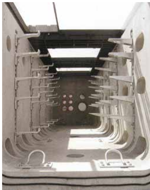
共同溝内部。 点検作業も容易 に行えます。
