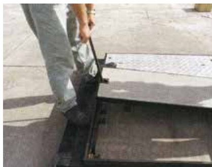
8 蓋が上がった側を手前に引き両側を引き上げる
