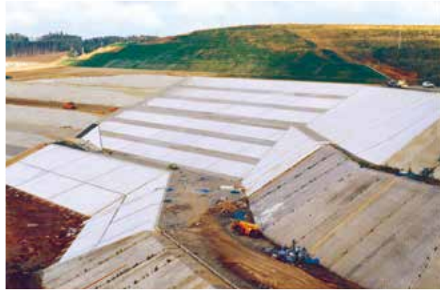
水資源開発公団＝長柄ダム 押え盛土のり面保護工 (FP100)
