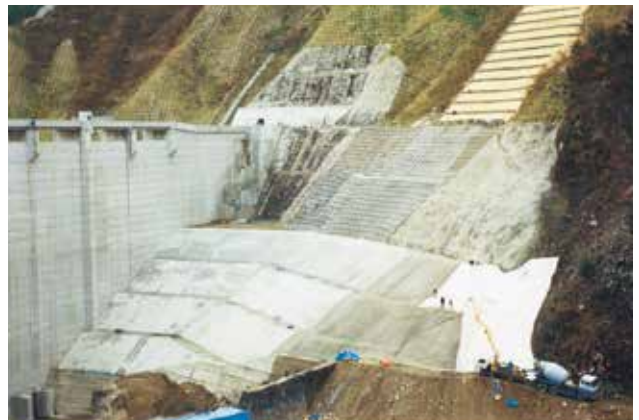
長野県＝片桐ダム 押え盛土のり面保護工 (FP100)
