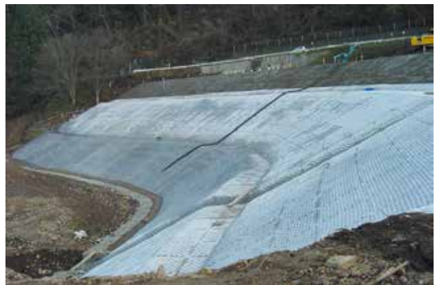
長野県＝据花ダム (FP100RJ)
