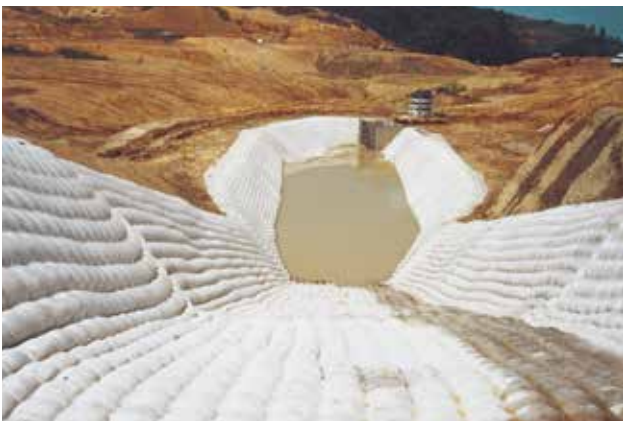
水資源開発公団＝打上調整池水路工 (CX300)
