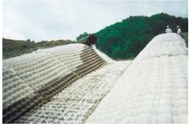
長野県＝県道改良付帯水路工 (CX200)
