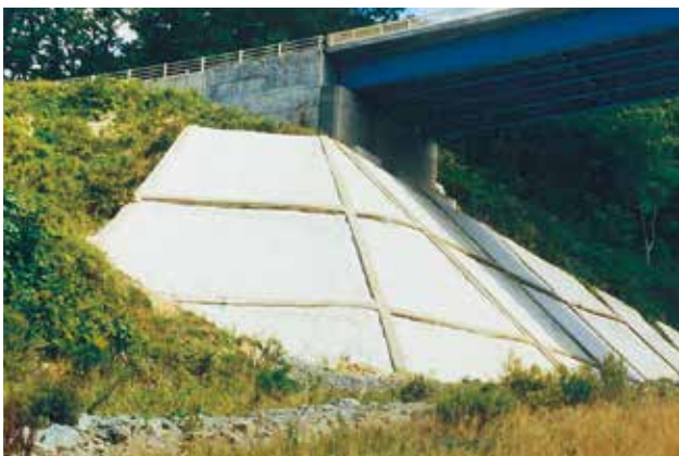
東北地整＝浅瀬石川ダム (NF150 水抜加工)
