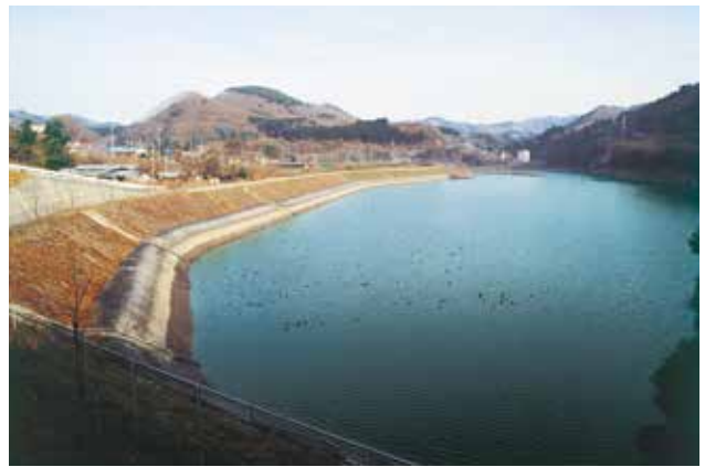
群馬県 = 高津戸発電所調整池 (CX200)
