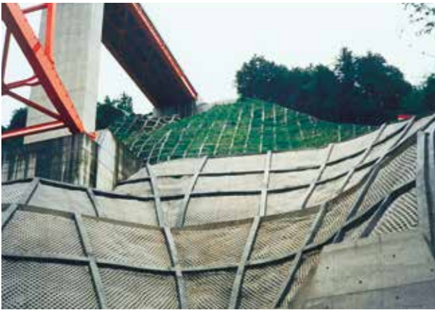
関東地整 = 宮ヶ瀬ダム 虹の大橋 (FP150)
