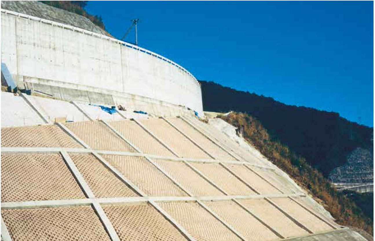
中部地整＝蓮ダム地山対策工 (FP150)
