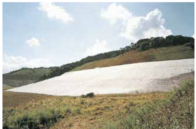
北陸農政局＝五位ダム押え盛土のり面保護工 (FP100-RJ)
