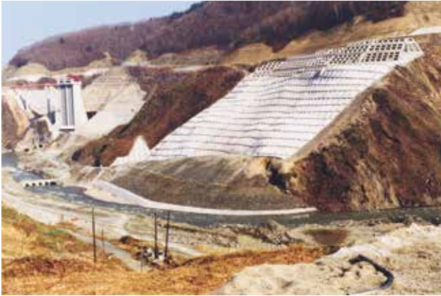
東北地整＝寒河江ダム 地山対策工 (FP150) 水路工 (CX300)
