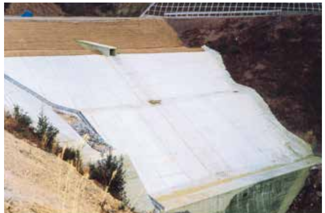
香川県＝千足ダム 押え盛土のり面保護工 (FP100-RJ)
