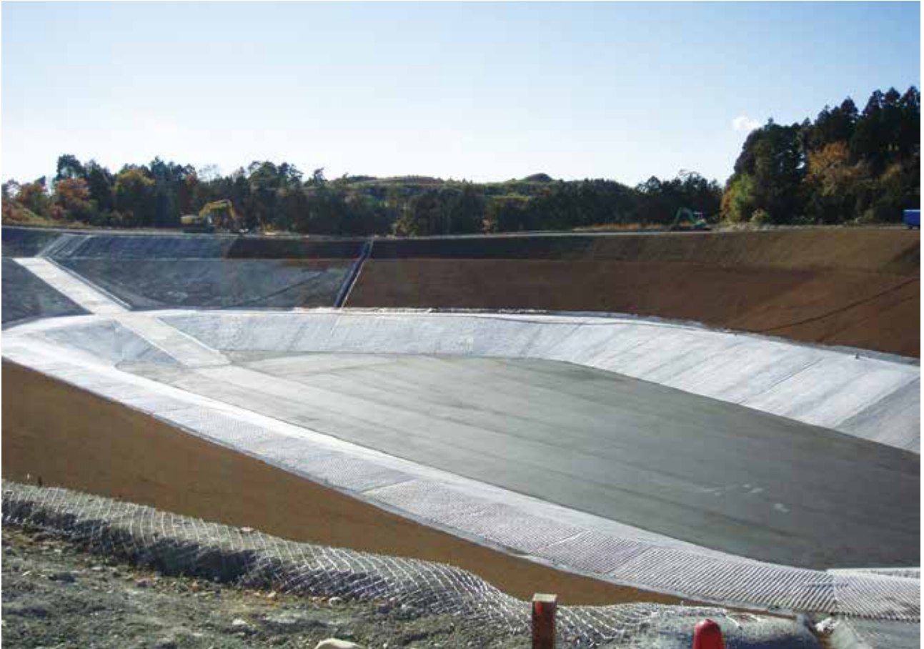
静岡県 = 空港調整池整備工事 (GP50&NF50)
