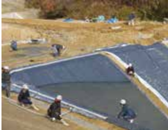
■モルタル注入
