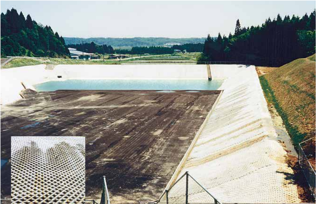
秋田市＝豊岩工業団地調整池 盛工部 (NF100) 切工部 (FP100) FP 水抜効果
