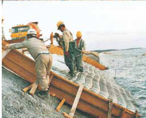
沖縄県＝糸満港防波護岸工 (CX500)
