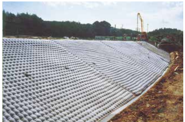
栃木県＝荒川災害復旧工 (CX300)
