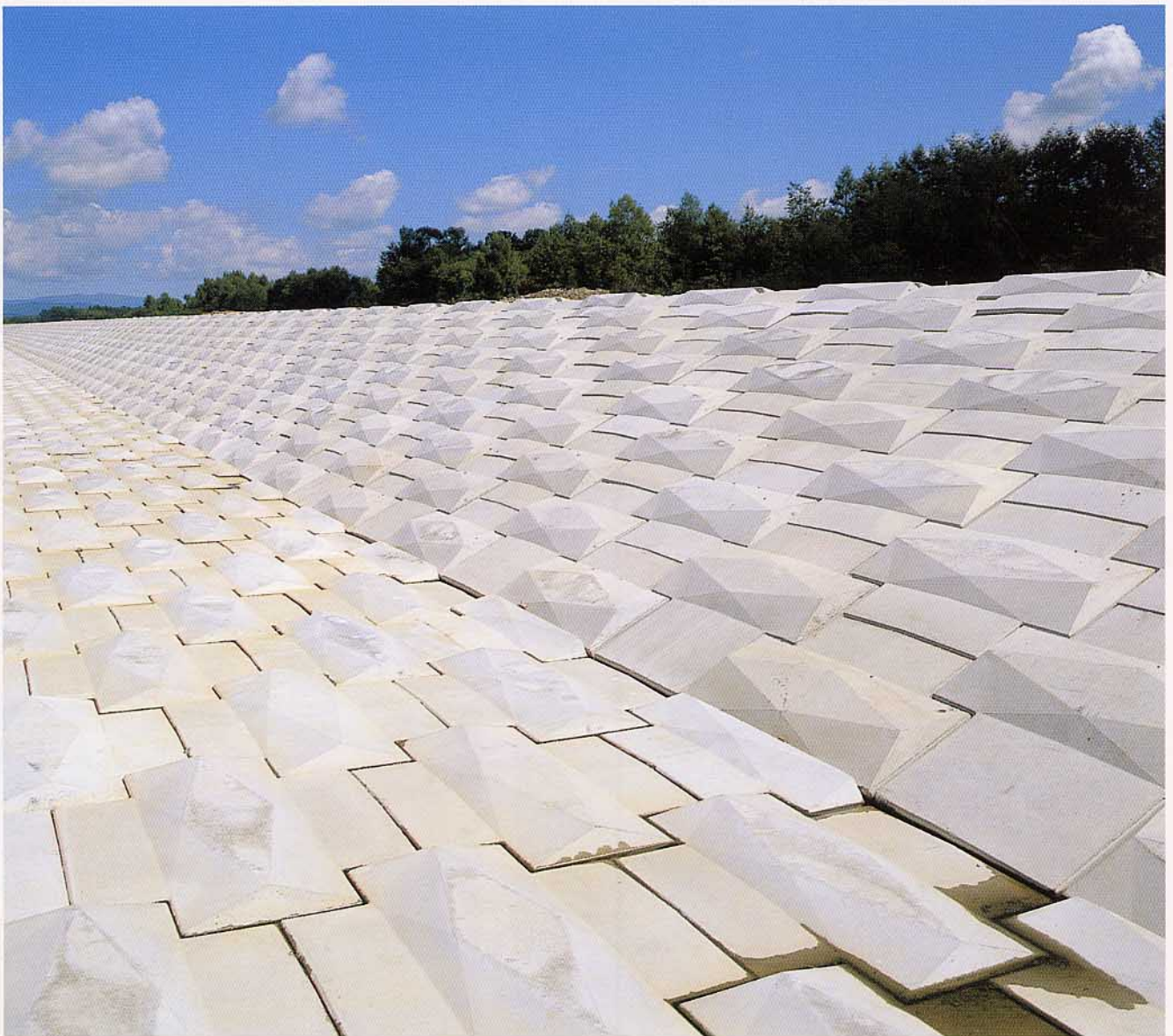
北海道 音更川改修工事
