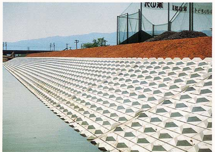
岐阜県 県単河川改良工事 中之江川
