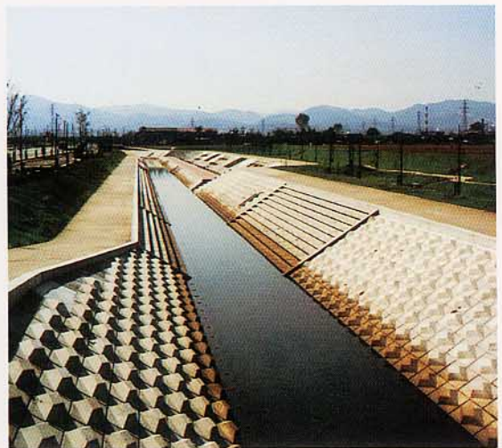
富山県 田島川改修工事
