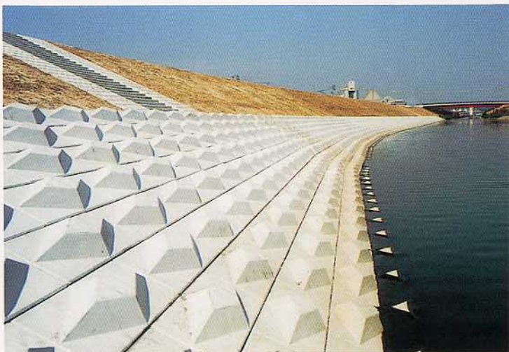
愛知県 中小河川改良工事 広田川
