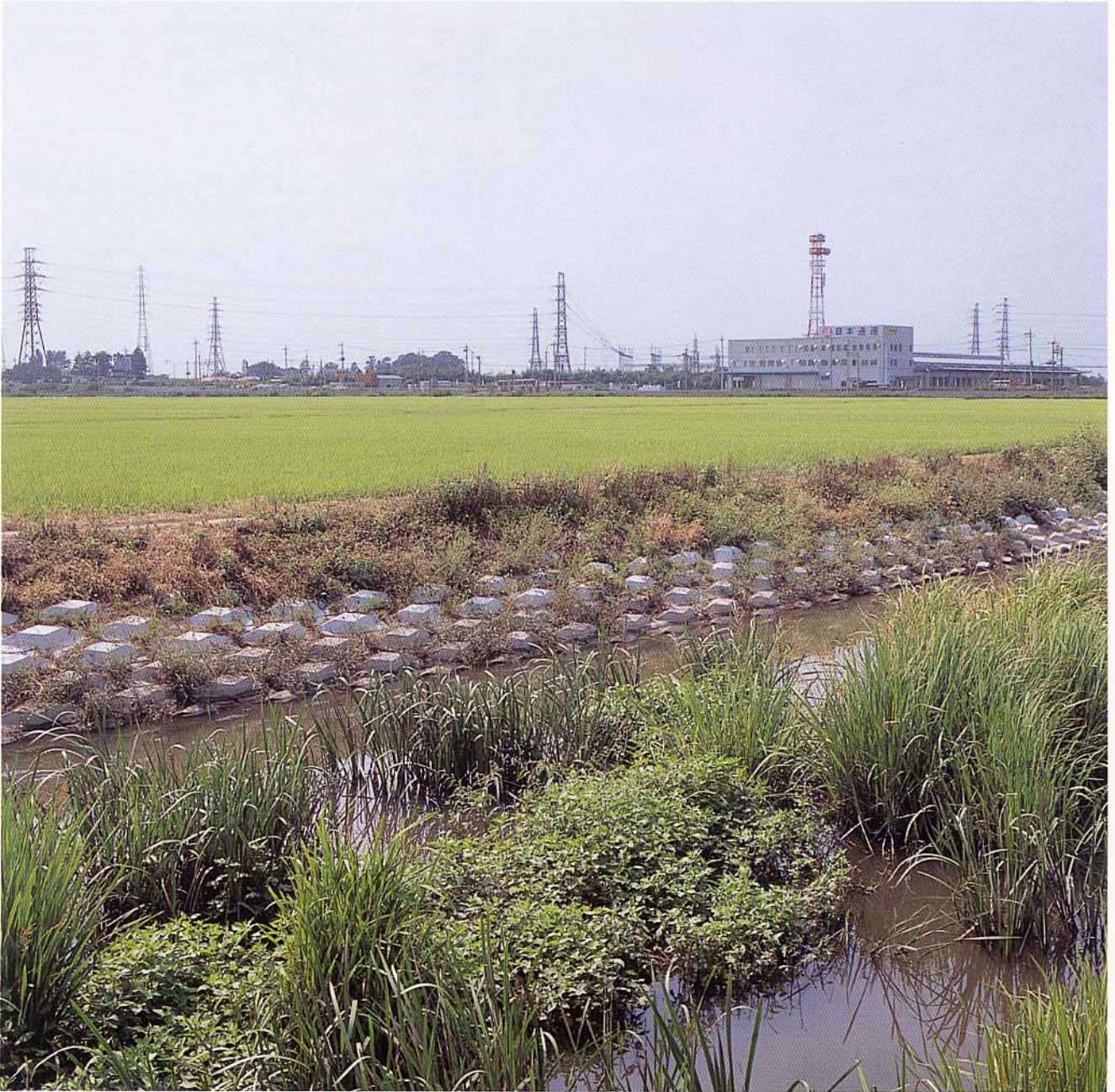
栃木県 国庫補助平成7年河川災害復旧工事
