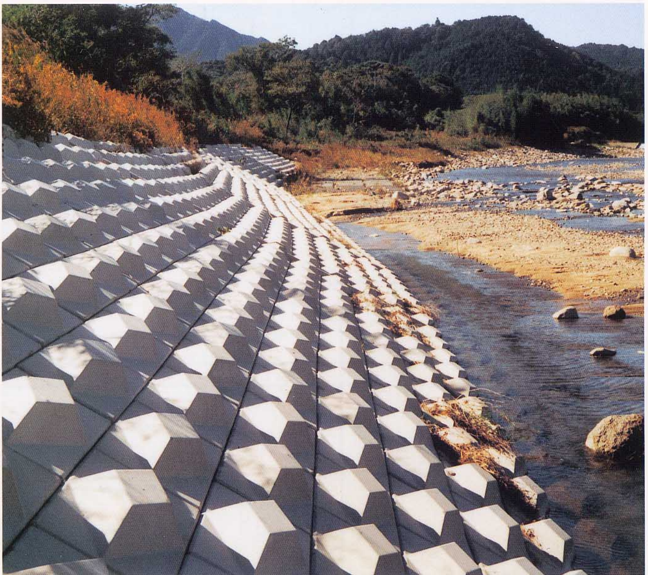
三重県 鈴鹿川底護岸補修工事
