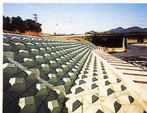
三重県 鈴鹿川大岡寺床固工補修工事
