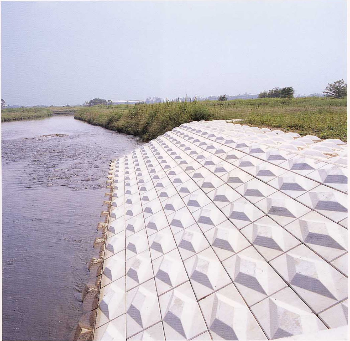
群馬県 澗川災害復旧工事
