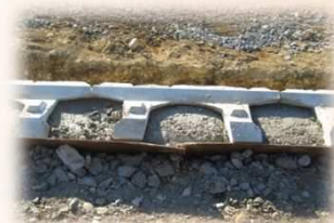
胴込コンクリート充填状況
