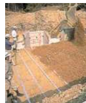
土のまき 出し
